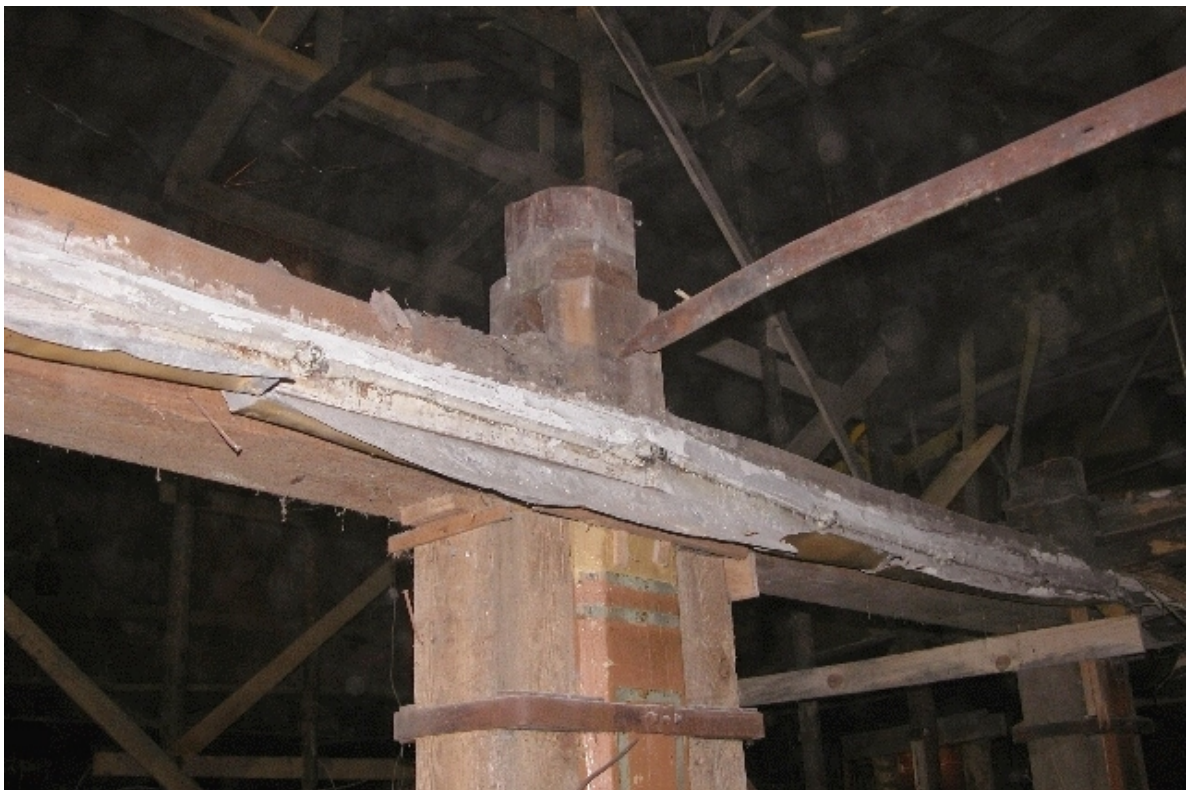
Fot. Nr 112 - Teatr Stary w Lublinie, ul. Jezuicka18,drewniane loże. Strop I kondygnacji w czasie prac rozbiórkowych. Wyk Małgorzata Podgórska - Makal . 11.10. 2007
