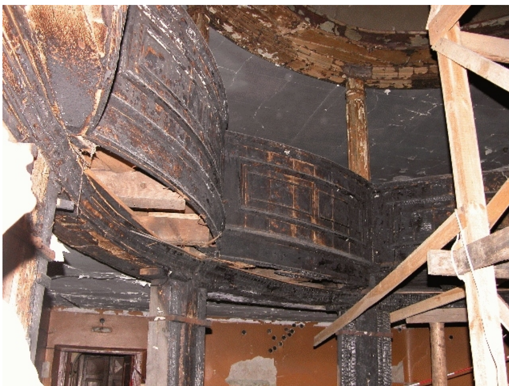
Fot. Nr 32 - Teatr Stary w Lublinie, ul. Jezuicka18,drewniane łoże, stan zachowania przed rozpoczęciem prac rozbiórkowych. II kondygnacja - łoże. Widoczne zniszczenia spowodowane pożarem .Wyk Małgorzata Podgórska - Makal . 03.07. 2007
