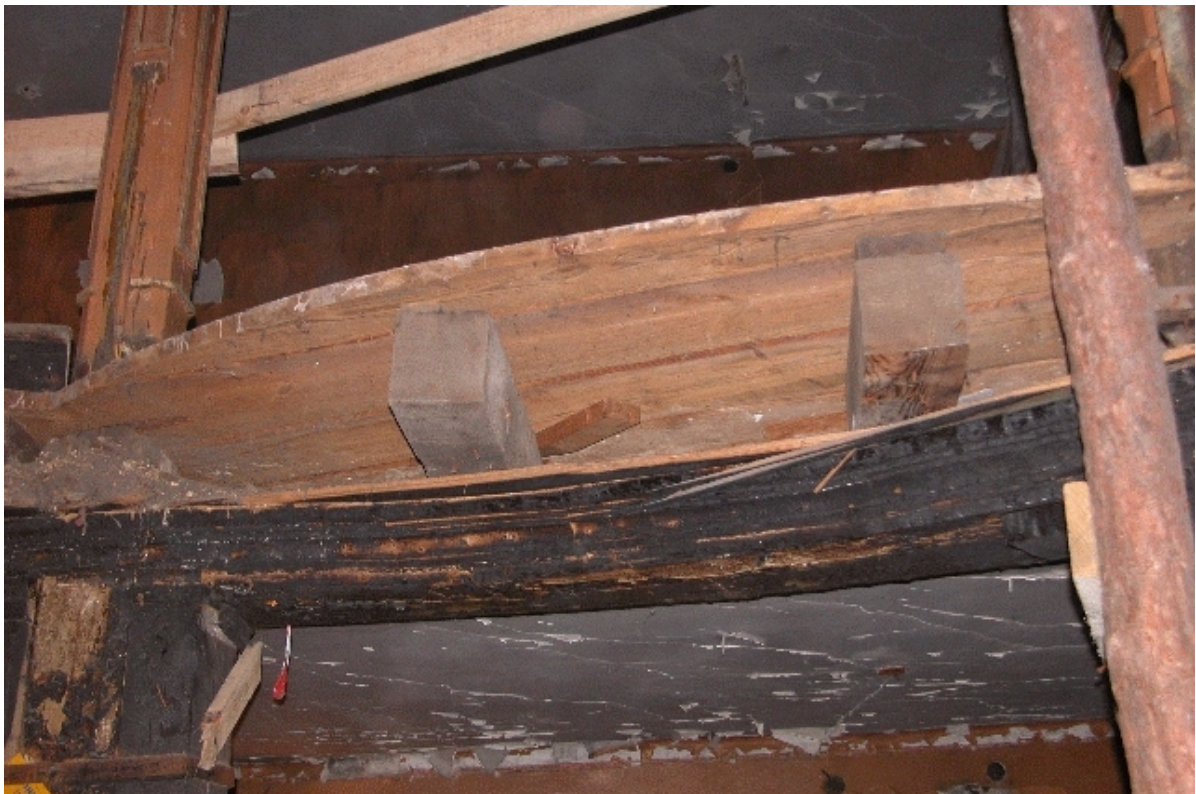
Fot. Nr 84 - Teatr Stary w Lublinie, ul. Jezuicka18,drewniane loże. Strop pomiędzy I i II kondygnacją w trakcie prac rozbiórkowych.Wyk Małgorzata Podgórska - Makal . 06.09. 2007
