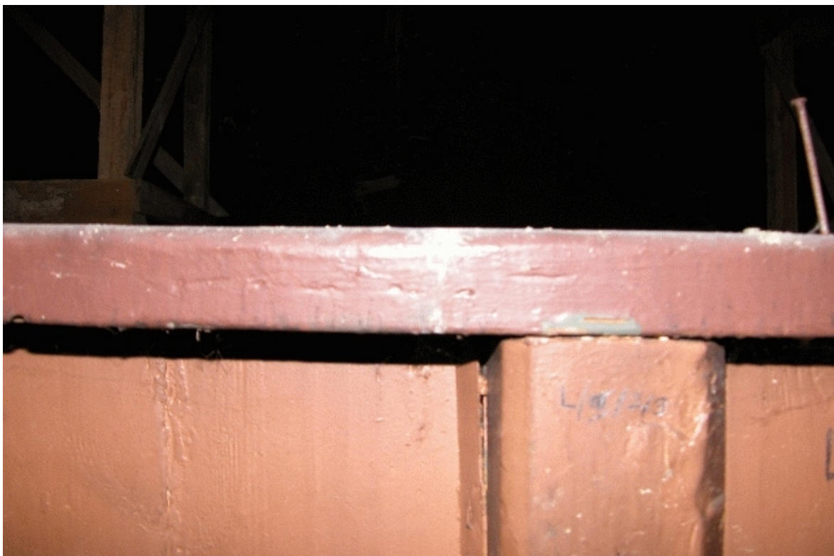
Fot. Nr 18 - Teatr Stary w Lublinie, ul. Jezuicka18,drewniane loże, stan zachowania przed rozpoczęciem prac rozbiórkowych. III kondygnacja łóż - galeria. Widok od strony miejsc dla publiczności. Wyk Małgorzata Podgórska - Makal . 20.08. 2007
