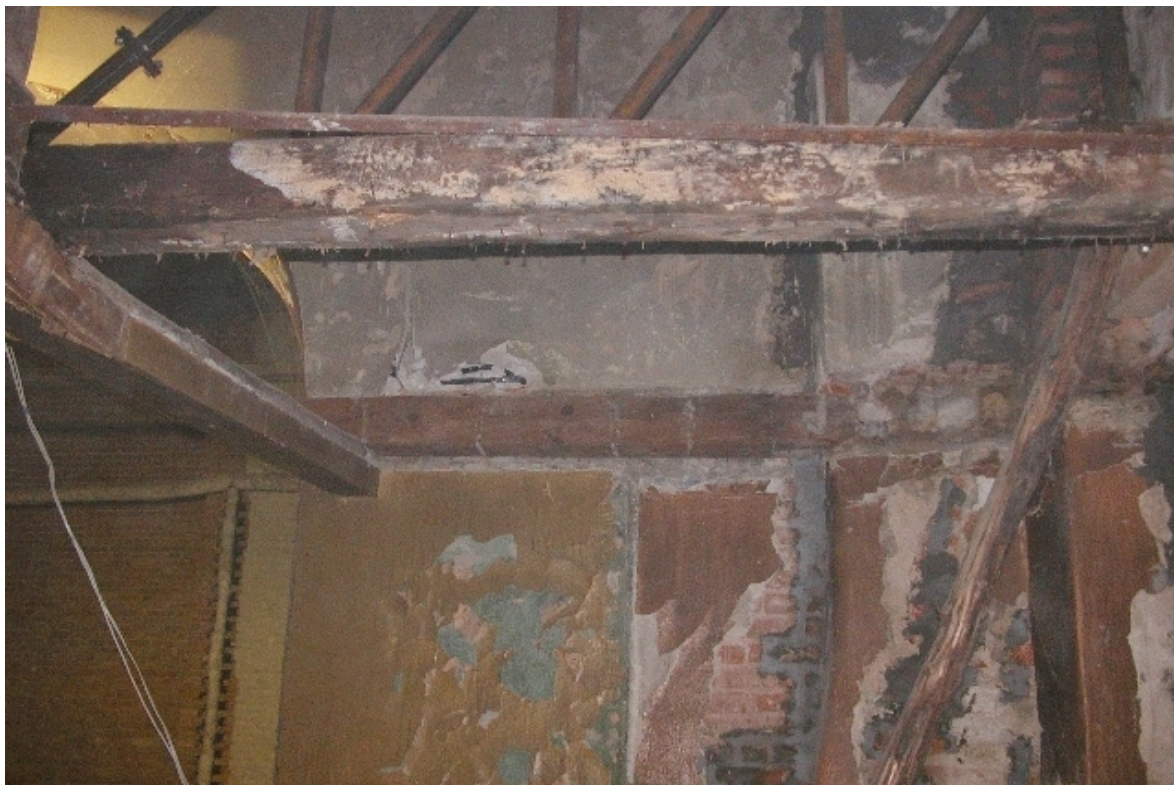
Fot. Nr 101 - Teatr Stary w Lublinie, ul. Jezuicka 18, drewniane łoże - I kondygnacja. Belki stropowe po ich odsłonięciu. Wyk Małgorzata Podgórska - Makal . 12.10. 2007
