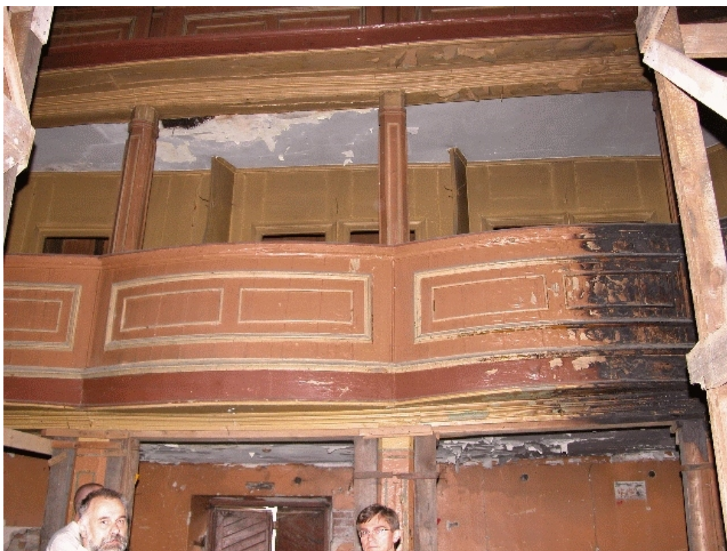
Fot. Nr 1 - Teatr Stary w Lublinie, ul. Jezuicka18,drewniane loże, stan zachowania przed rozpoczęciem prac rozbiórkowych. Wyk Małgorzata Podgórska - Makal . 03.07. 2007
