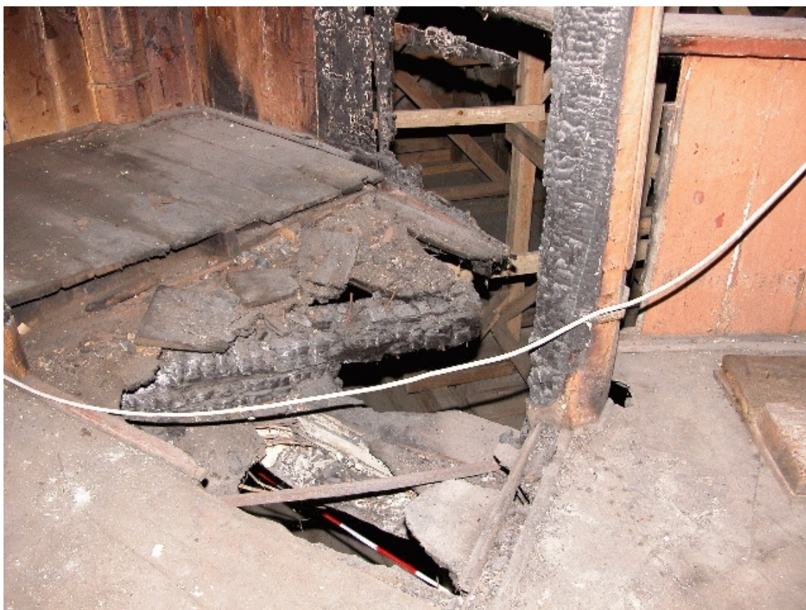
Fot. Nr 33 - Teatr Stary w Lublinie, ul. Jezuicka18,drewniane loże, II kondygnacja - loże. Stan zachowania przed demontażem. Wyk Małgorzata Podgórska - Makal . 20.08. 2007
