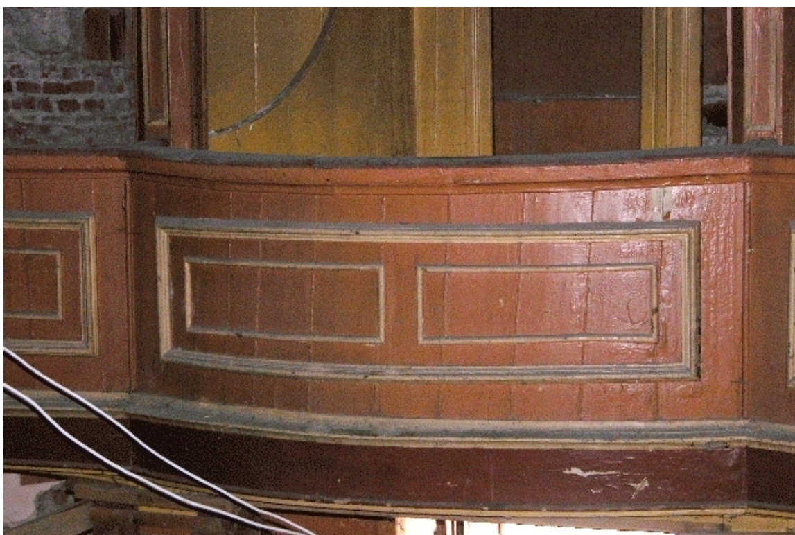
Fot. Nr 34 - Teatr Stary w Lublinie, ul. Jezuicka18,drewniane loże, stan zachowania przed rozpoczęciem prac rozbiórkowych.II kondygnacja - loże. Wyk Małgorzata Podgórska - Makal . 20.08. 2007
