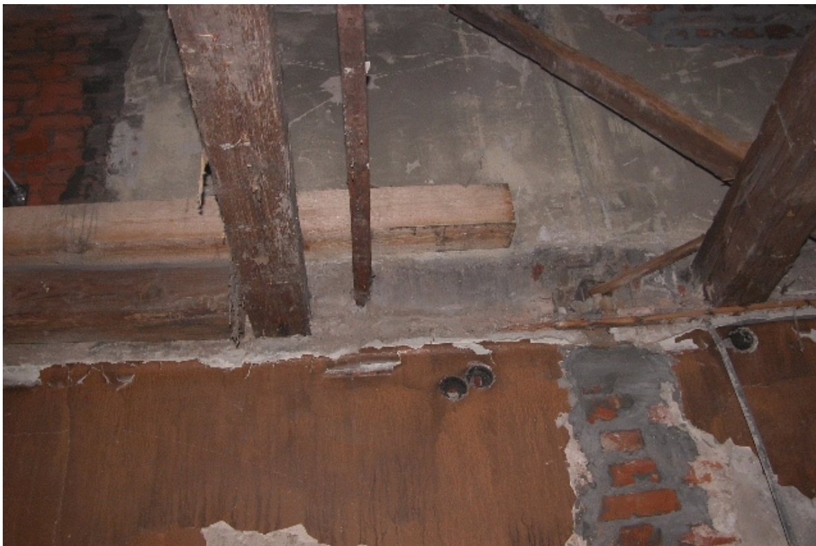
Fot. Nr 103 - Teatr Stary w Lublinie, ul. Jezuicka18,drewniane loże, I kondygnacja Belki stropowe po ich odsłonięciu. Wyk Małgorzata Podgórska - Makal . 12.10. 2007
