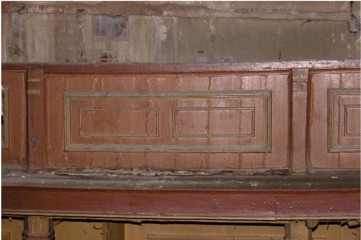
Fot. Nr 5 - Teatr Stary w Lublinie, ul. Jezuicka 18, drewniane łóże, stan zachowania przed rozpoczęciem prac rozbiórkowych. III kondygnacja łóż - galeria. Wyk Małgorzata Podgórska - Makal . 20.08. 2007
