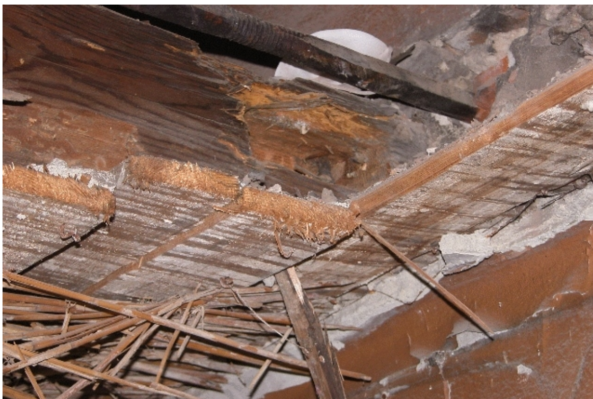
Fot. Nr 115 - Teatr Stary w Lublinie, ul. Jezuicka18,drewniane loże. Strop I kondygnacji w czasie prac rozbiórkowych. Wyk Małgorzata Podgórska - Makal . 11.10. 2007
