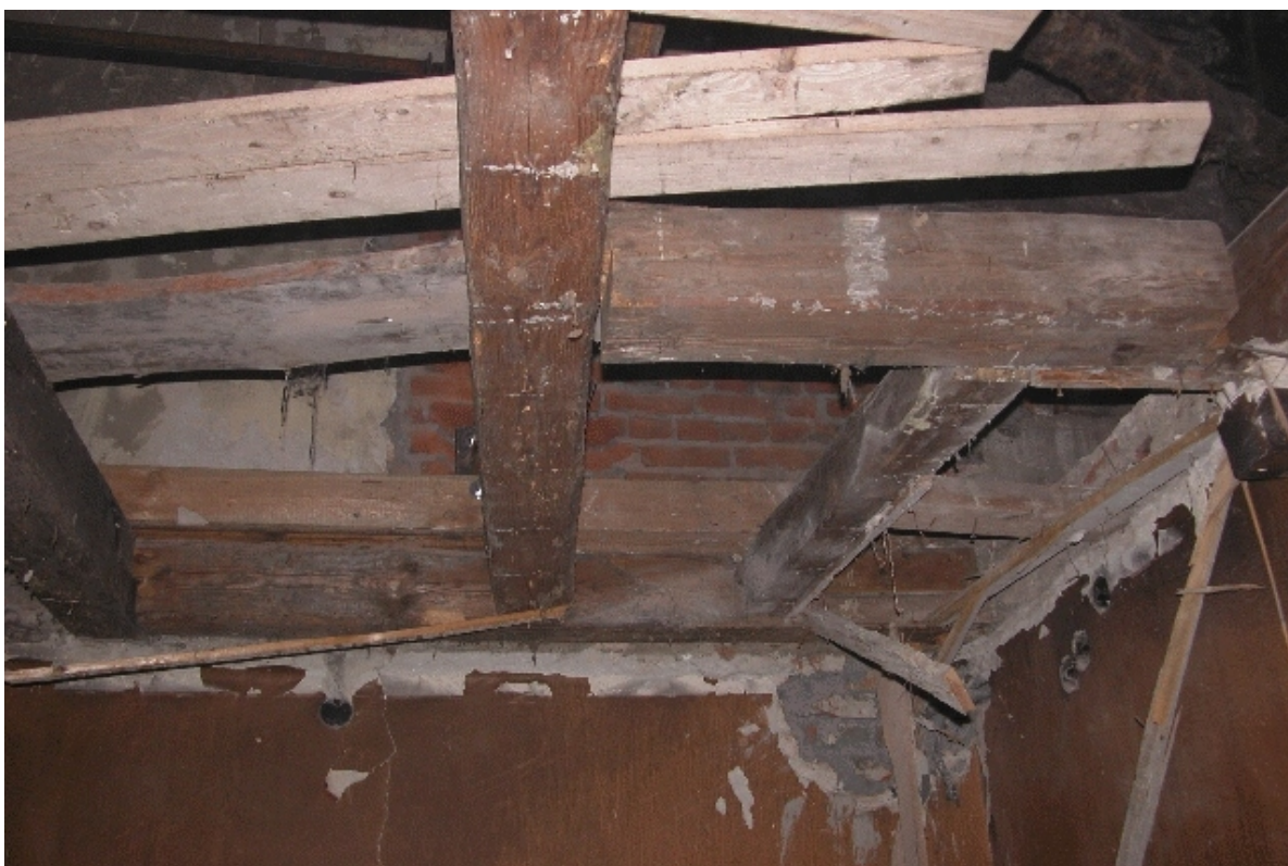
Fot. Nr 104 - Teatr Stary w Lublinie, ul. Jezuicka18,drewniane loże. Belki stropowe I kondygnacji łóż po ich odsłonięciu. Wyk Małgorzata Podgórska - Makal . 12.10. 2007
