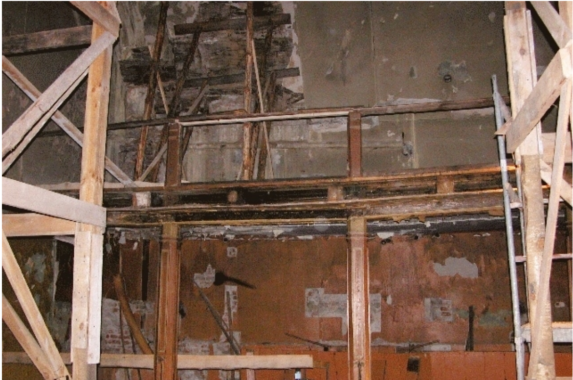
Fot. Nr 81 - Teatr Stary w Lublinie, ul. Jezuicka18,drewniane loże.Widok po zdemontowaniu balustrady galerii, balkonów i deski cokołowej wysłaniającej belki stropowe.Widoczne belki stropowe. Wyk Małgorzata Podgórska - Makal . 06.09. 2007
