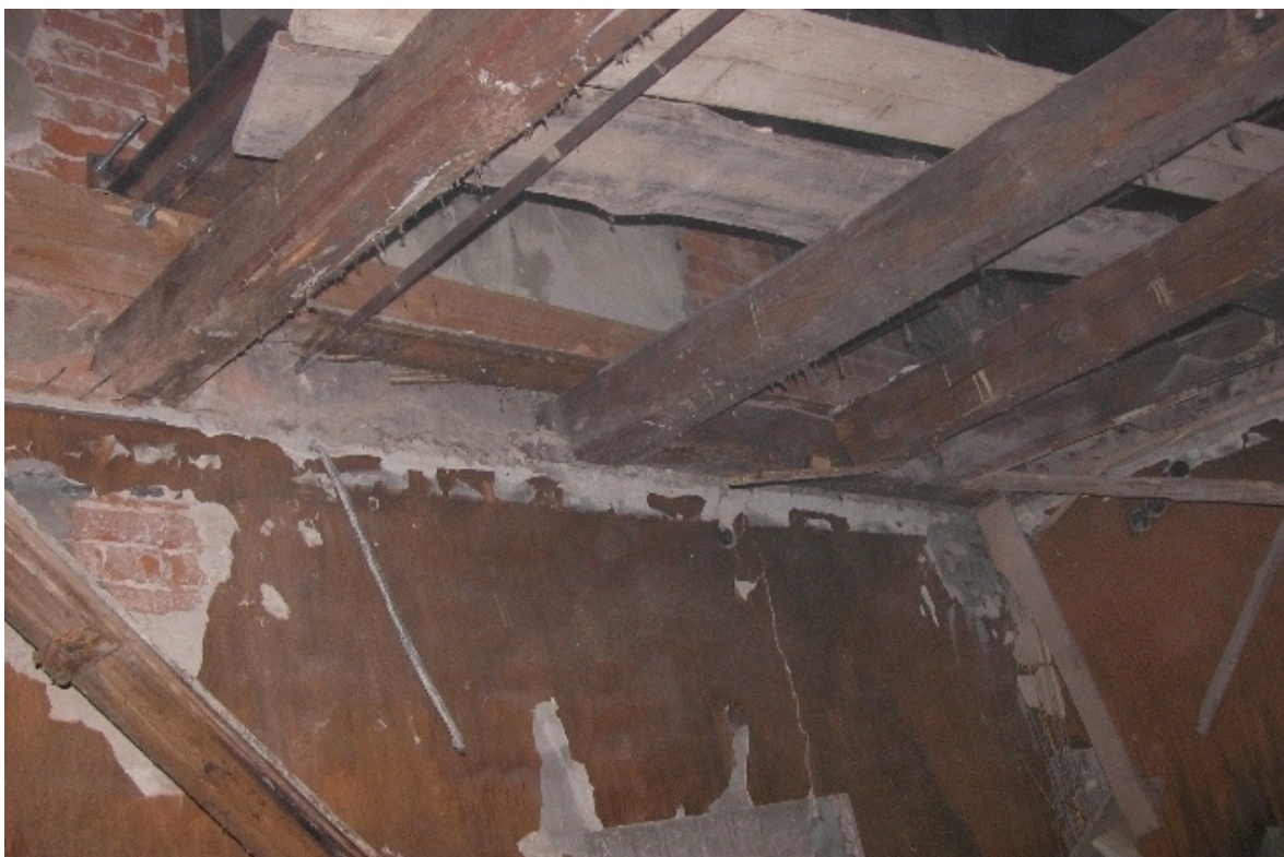
Fot. Nr 100 - Teatr Stary w Lublinie, ul. Jezuicka18, drewniane łoże. Strop I kondygnacji w czasie prac rozbiórkowych. Wyk. Małgorzata Podgórska-Makal 12.10.2007
