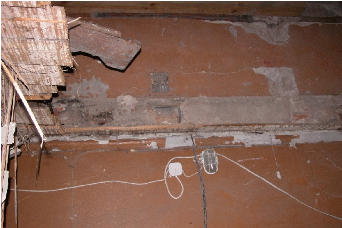
Fot. Nr 108 - Teatr Stary w Lublinie, ul. Jezuicka18,drewniane łoże, Strop I kondygnacji w czasie prac rozbiórkowych.Widoczne gniazda po belkach stropowych. Wyk. Małgorzata Podgórska-Makał 12.10.2007
