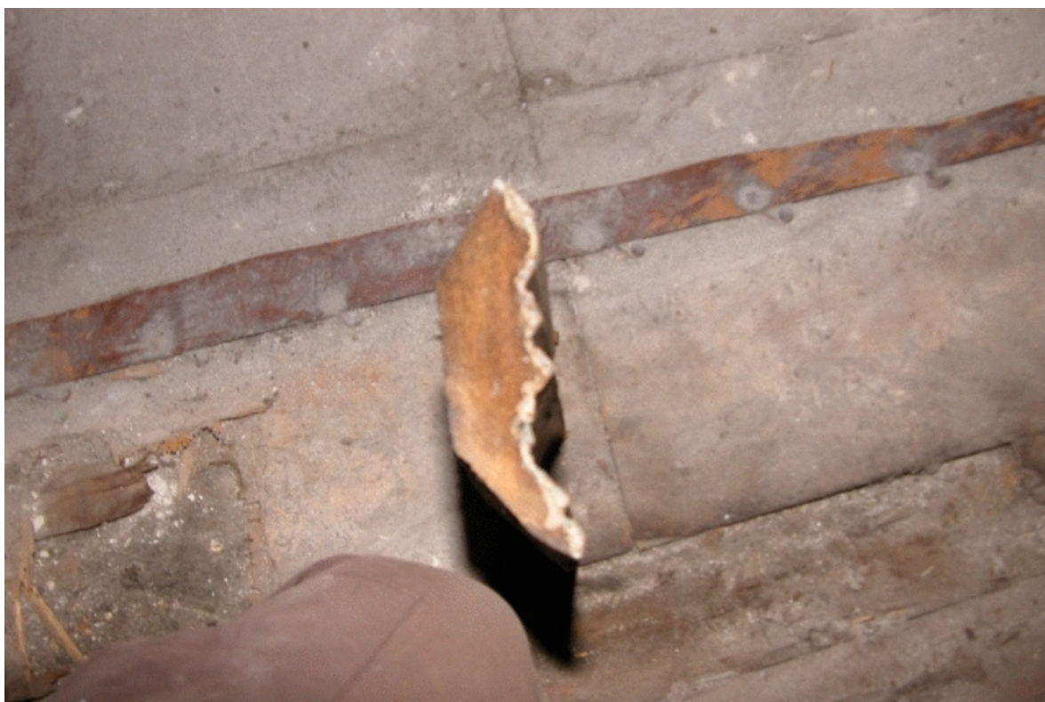
Fot. Nr 66 - Teatr Stary w Lublinie, ul. Jezuicka18,drewniane loże. Zdjęcie przekroju listwy profilowanej .Wyk Małgorzata Podgórska - Makal . 23.08. 2007
