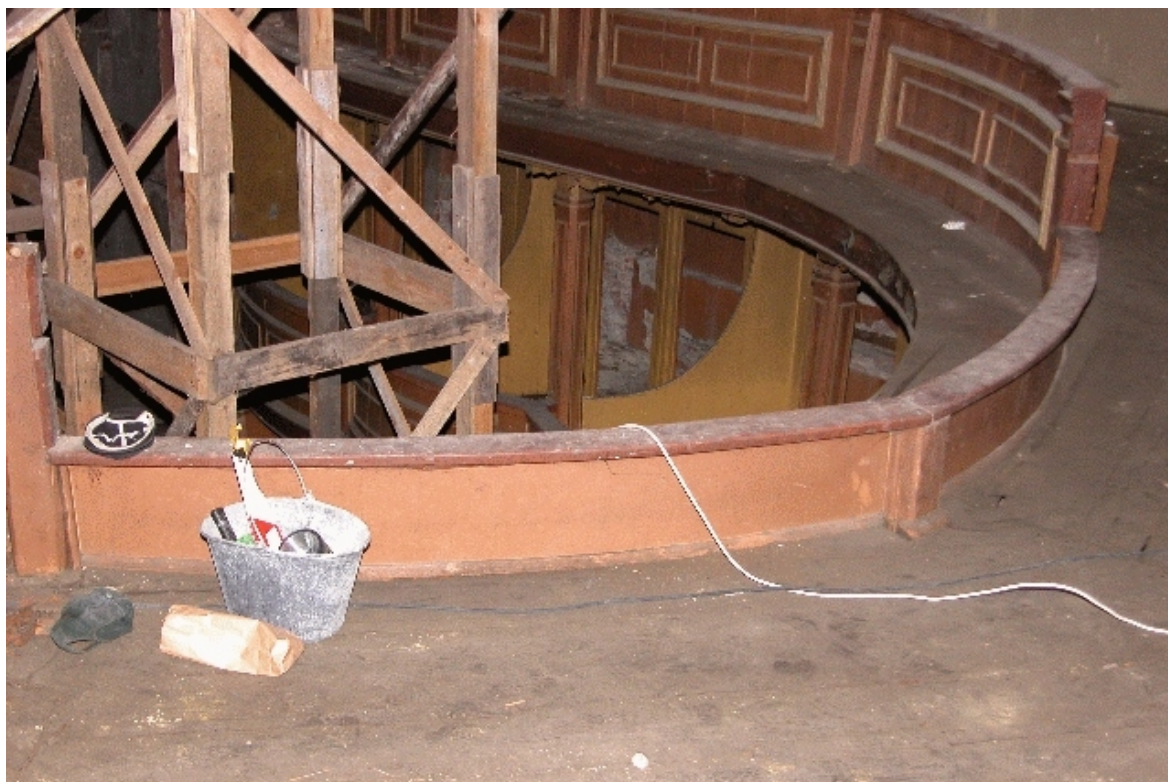
Fot. Nr 9 - Teatr Stary w Lublinie, ul. Jezuicka18,drewniane loże, stan zachowania przed rozpoczęciem prac rozbiórkowych. III kondygnacja łóż - galeria. Wyk Małgorzata Podgórska - Makal . 20.08. 2007
