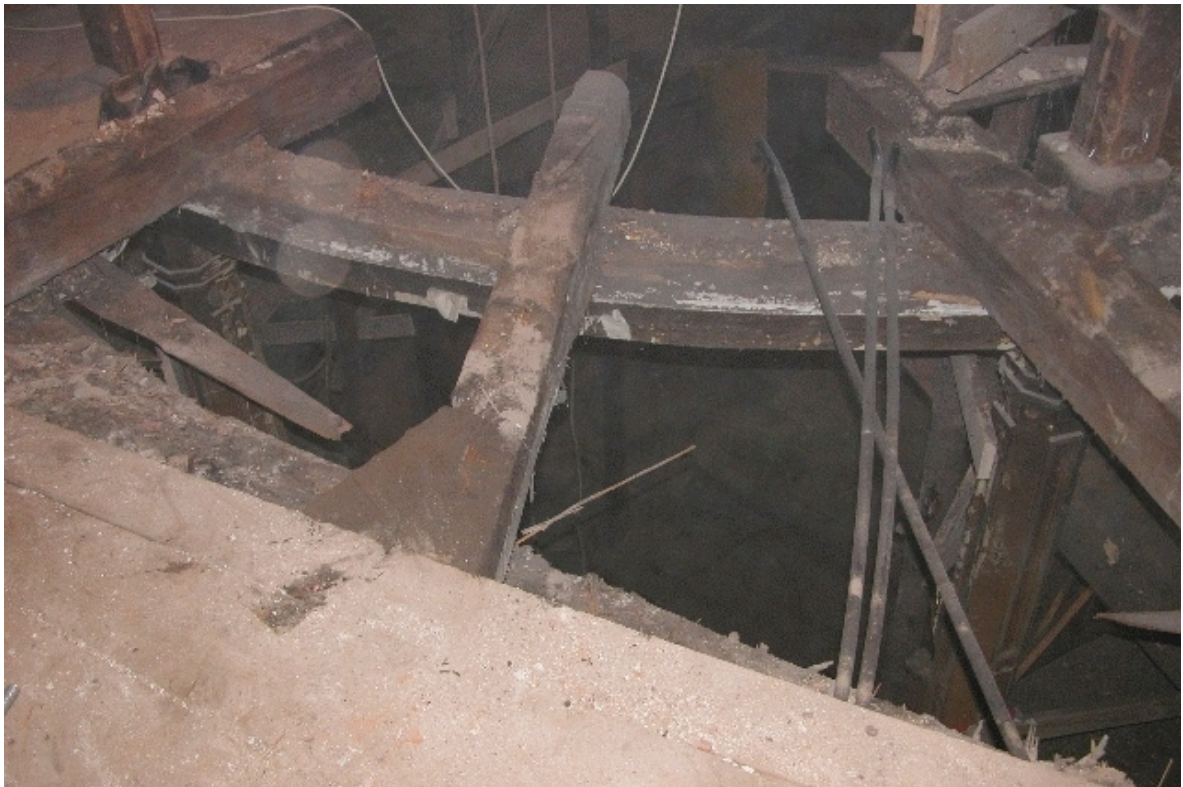
Fot. Nr 91 - Teatr Stary w Lublinie, ul.. Jezuicka18, strop nad II kondygnacją w czasie prac rozbiórkowych. Wyk Małgorzata Podgórska - Makal . 10.10. 2007
