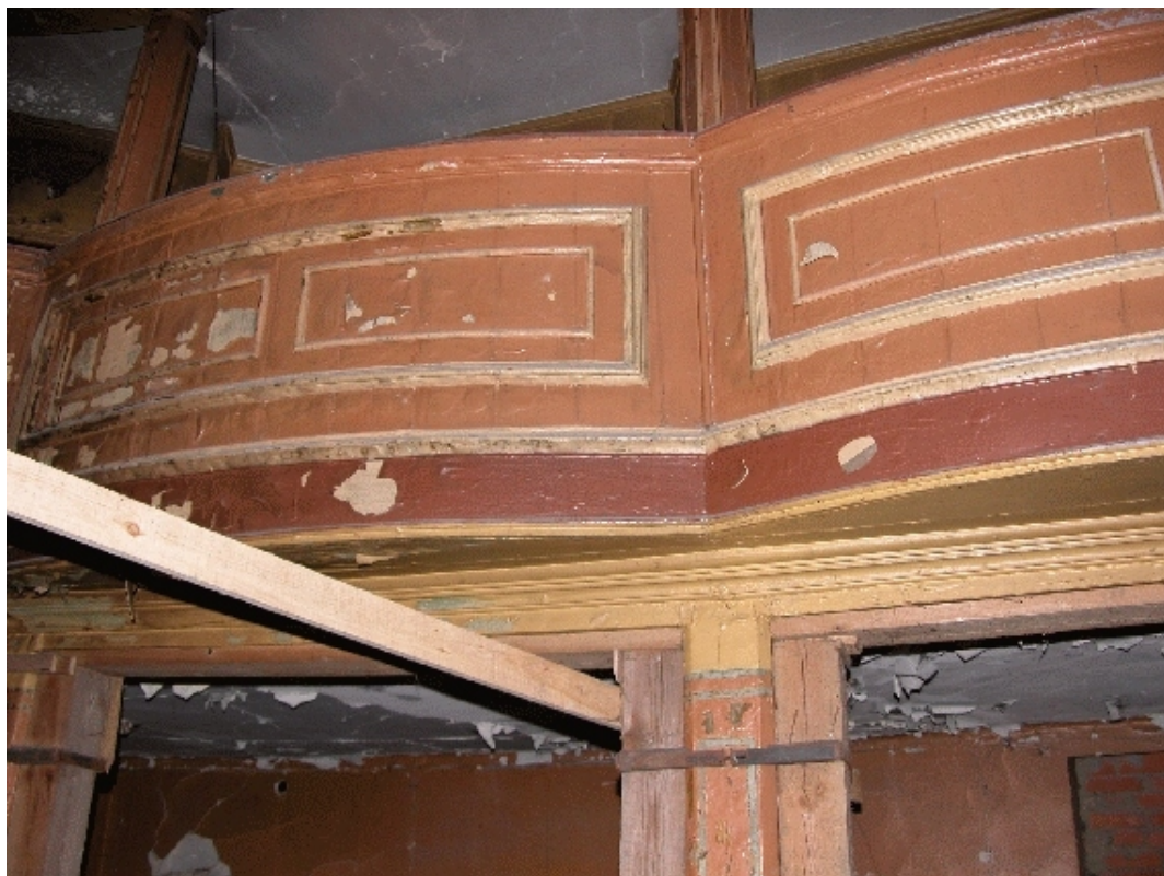
Fot. Nr 22 - Teatr Stary w Lublinie, ul. Jezuicka 18, drewniane łoże, stan zachowania przed rozpoczęciem prac rozbiórkowych, II kondygnacja - balkony. Wyk Małgorzata Podgórska - Makal . 03.07. 2007
