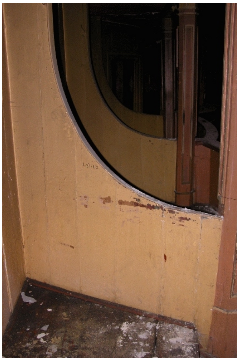
Fot. Nr 57 - Teatr Stary w Lublinie, ul. Jezuicka 18, drewniane łoże, II kondygnacja. Ścianki oddzielające poszczególne łoże. Wyk Małgorzata Podgórska - Makal . 20.08. 2007
