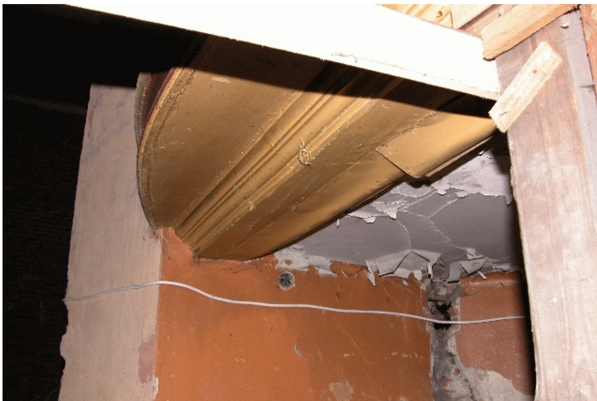
Fot. Nr 59 - Teatr Stary w Lublinie, ul. Jezuicka18,drewniane łoże, I kondygnacja łóż - parter. Stan zachowania sufitów. Wyk Małgorzata Podgórska - Makal . 20.08. 2007
