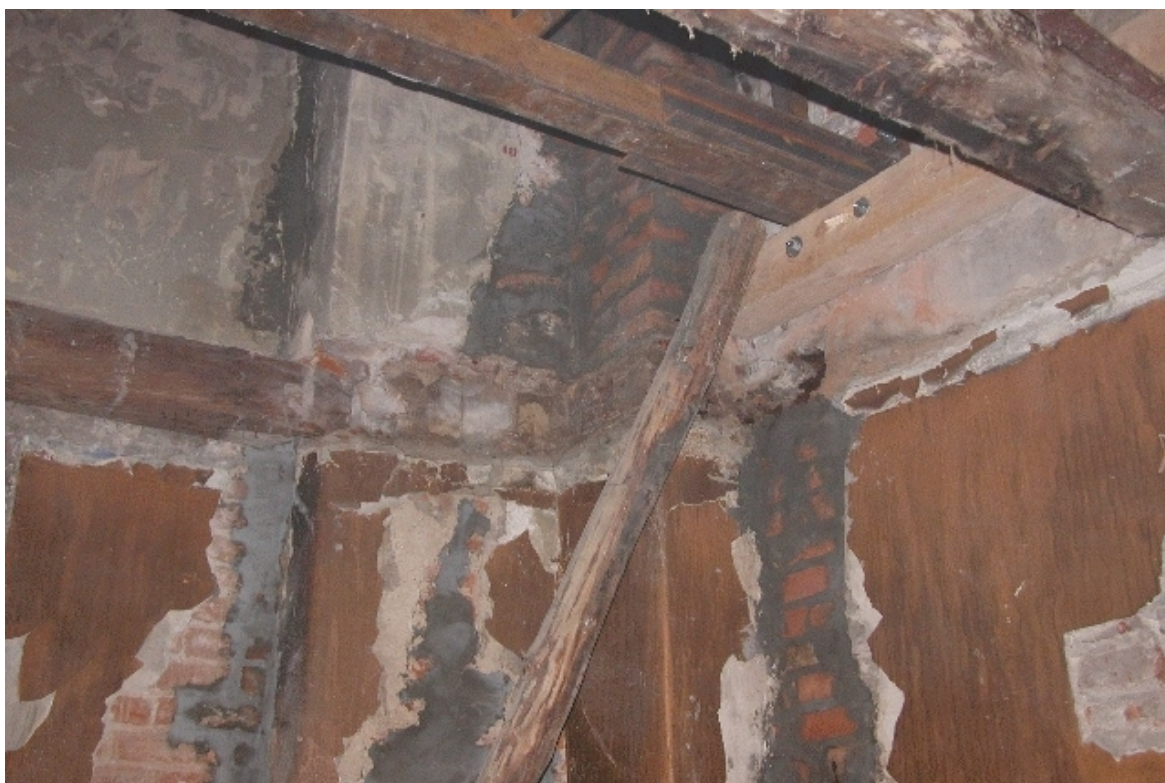
Fot. Nr 96 - Teatr Stary w Lublinie, ul. Jezuicka18,„drewniane loże. Widoczne belki stropowe II kondygnacji.Wyk. Małgorzata Podgórska-Makal 10.10.2007
