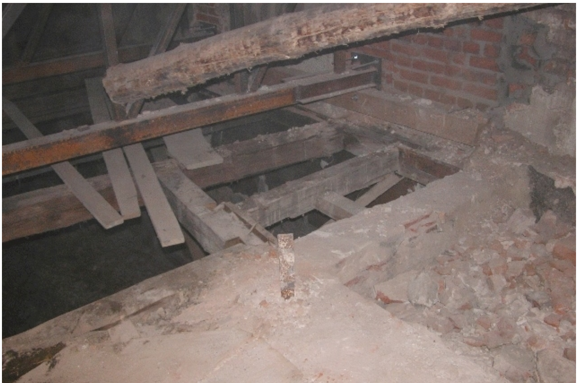
Fot. Nr 92 - Teatr Stary w Lublinie, ul. Jezuicka18, drewniane łożo, strop nad II kondygnacją w czasie prac rozbiórkowych. Wyk Małgorzata Podgórska - Makal . 10.10. 2007
