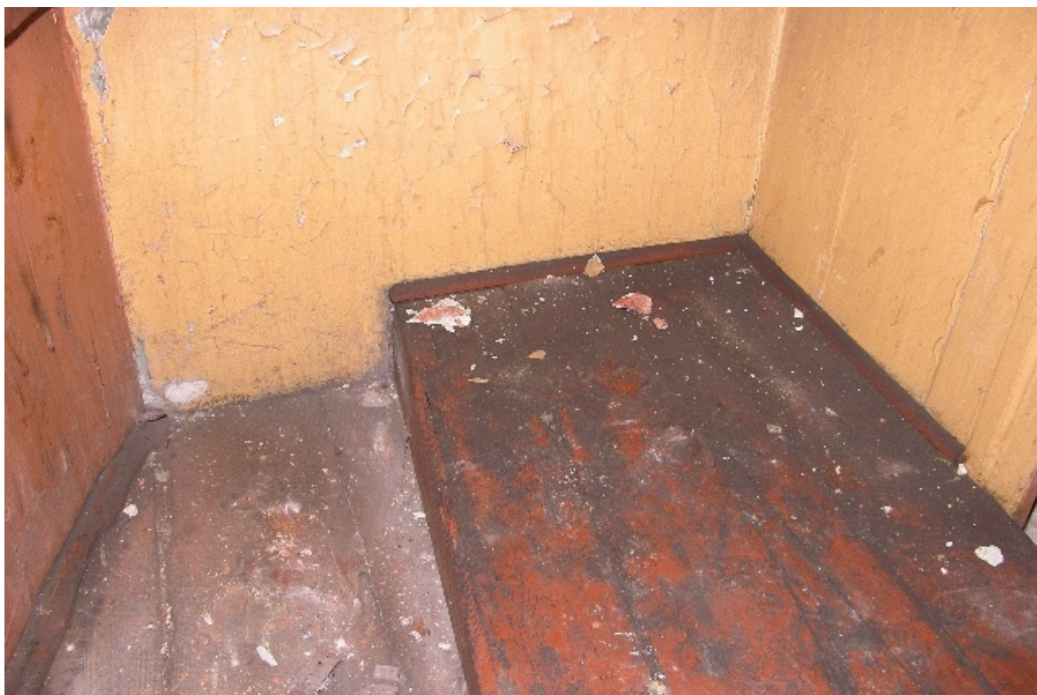
Fot. Nr 53 - Teatr Stary w Lublinie, ul. Jezuicka18, drewniane loże, stan zachowania przed rozpoczęciem prac rozbiórkowych. II kondygnacja. Podłoga we wnętrzu loży. Wyk Małgorzata Podgórska - Makal . 20.08. 2007
