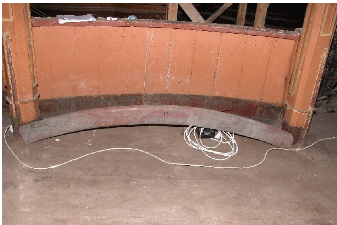
Fot. Nr 68 - Teatr Stary w Lublinie, ul. Jezuicka18,drewniane loże, II kondygnacja. Łoża L/2/8 .Wyk Małgorzata Podgórska - Makal . 23.08. 2007
