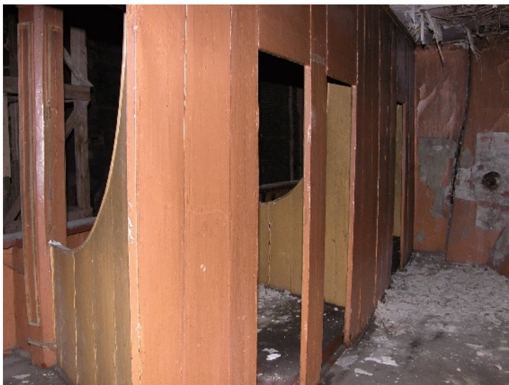
Fot. Nr 28 - Teatr Stary w Lublinie, ul. Jezuicka18, drewniane loże, stan zachowania przed rozpoczęciem prac rozbiórkowych. II kondygnacja łóż - balkony. Widoczne ścianki oddzielające poszczególne loże widowni .Wyk Małgorzata Podgórska - Makal . 03.07. 2007
