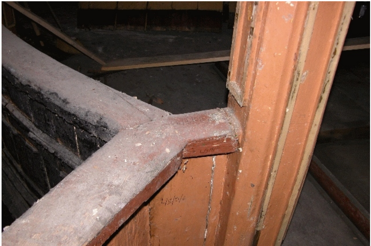
Fot. Nr 79 - Teatr Stary w Lublinie, ul. Jezuicka18,drewniane łoże - II kondygnacja. Oparcie balustrady. L/II/3/6. Wyk Małgorzata Podgórska - Makal . 28.08. 2007
