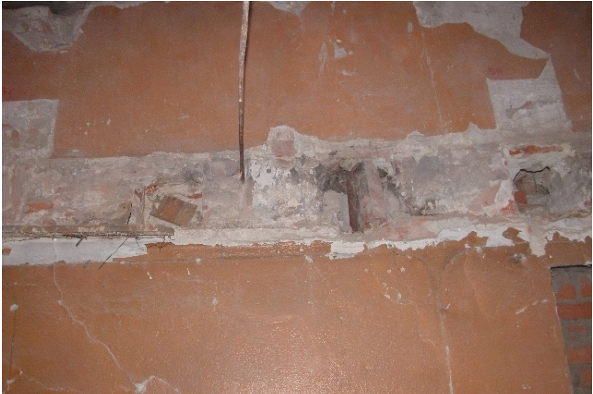
Fot. Nr 111 - Teatr Stary w Lublinie, ul. Jezuicka18,drewniane loże.Strop I kondygnacji w czasie prac rozbiórkowych. Widoczne gniazda po belkach stropowych. Wyk Małgorzata Podgórska - Makal . 12.10. 2007
