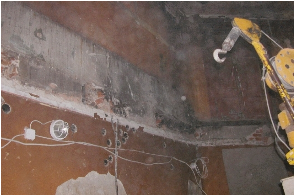
Fot. Nr 98 - Teatr Stary w Lublinie, ul. Jezuicka 18, drewniane łoże, Widoczne gniazda po belkach stropowych II kondygnacji. Wyk. Małgorzata Podgórska-Makal 12.10.2007
