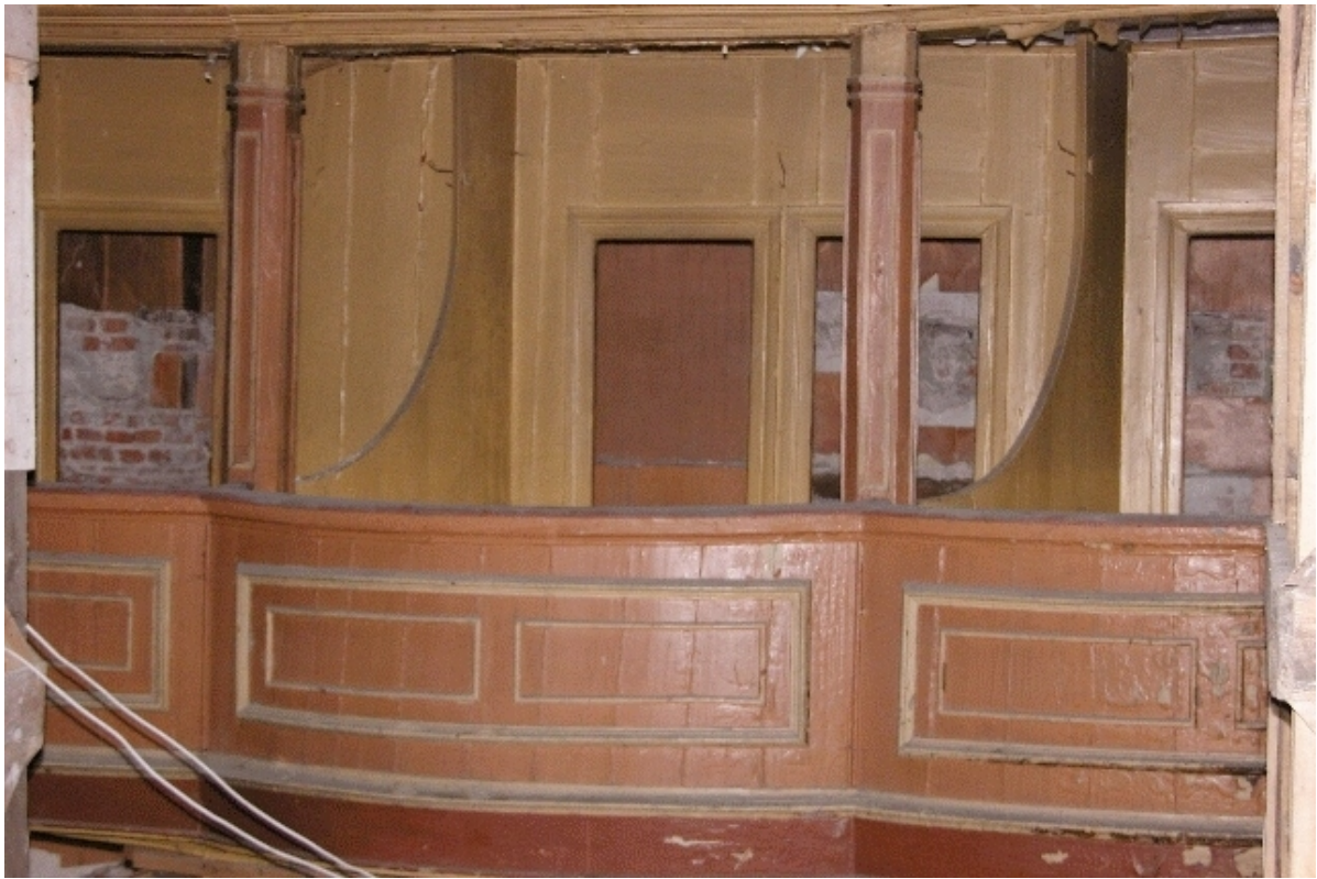
Fot. Nr 41 - Teatr Stary w Lublinie, ul. Jezuicka18, drewniane łoże, II kondygnacja - łoże. Stan zachowania przed demontażem. Wyk Małgorzata Podgórska - Makal . 20.08. 2007
