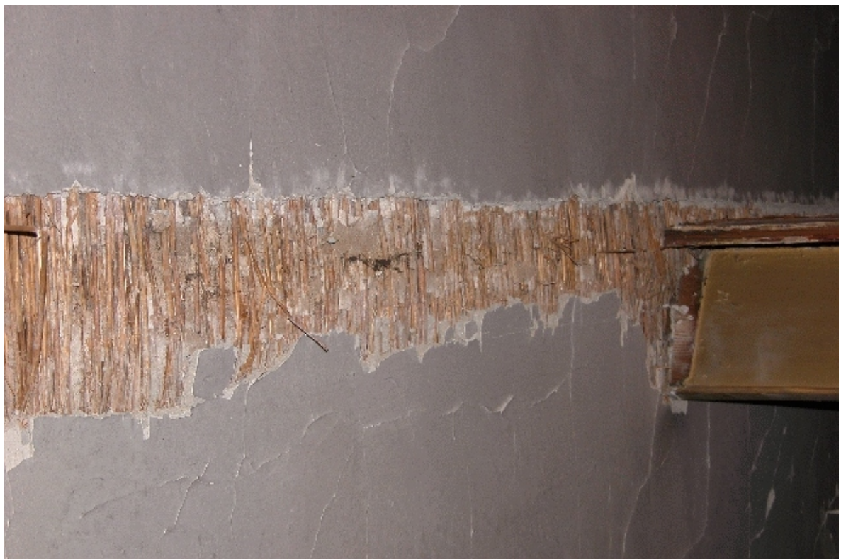
Fot. Nr 80 - Teatr Stary w Lublinie, ul. Jezuicka18,drewniane łoże - II kondygnacja łóż. Widok sufitu po zdemontowaniu ścianek zamykających łoże. Wyk Małgorzata Podgórska - Makal . 22.08. 2007
