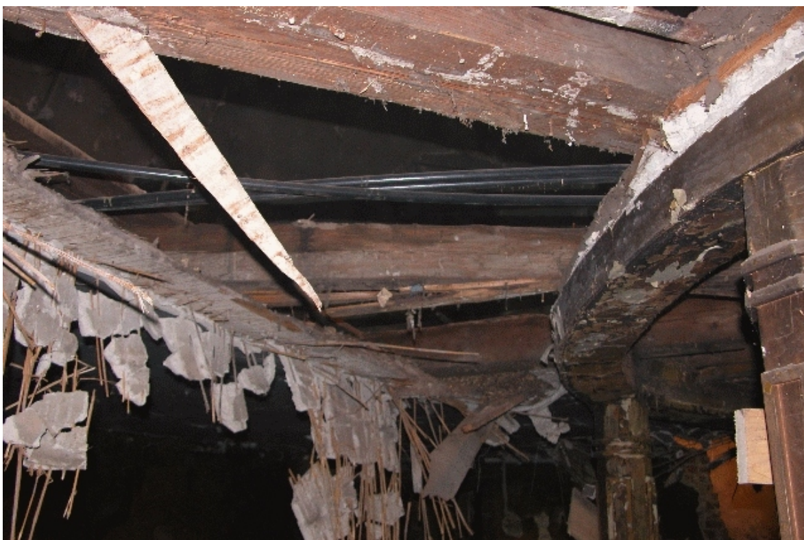
Fot. Nr 106 - Teatr Stary w Lublinie, ul. Jezuicka18,drewniane loże, Strop I kondygnacji w czasie prac rozbiórkowych.Wyk. Małgorzata Podgórska-Makal 12.10.2007
