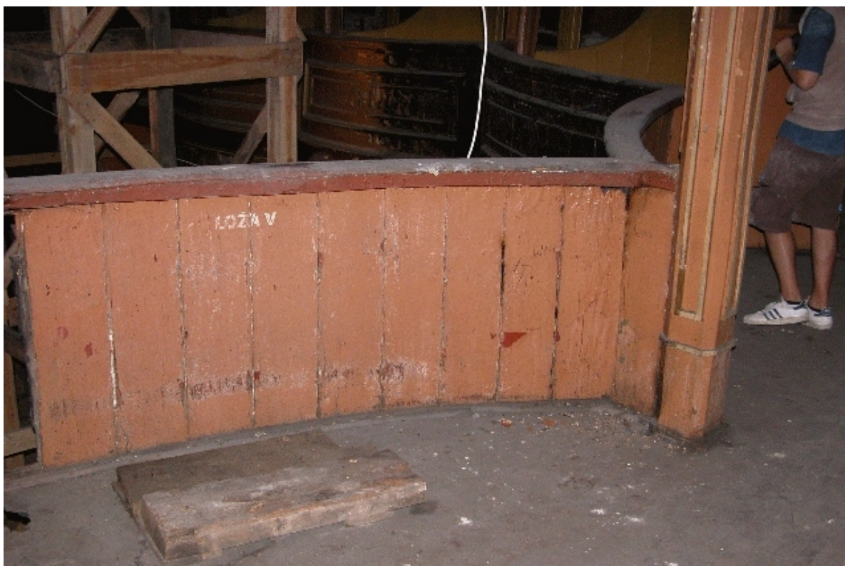
Fot. Nr 46 - Teatr Stary w Lublinie, ul. Jezuicka 18, drewniane loże, stan zachowania przed rozpoczęciem prac rozbiórkowych. II kondygnacja. Stan zachowania balkonów od strony widowni. Loża nr V. .Wyk Małgorzata Podgórska - Makal . 20.08. 2007
