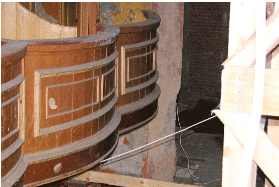
Fot. Nr 38 - Teatr Stary w Lublinie, ul. Jezuicka18, drewniane loże, stan zachowania przed rozpoczęciem prac rozbiórkowych. II kondygnacja - loże. Wyk Małgorzata Podgórska - Makal . 20.08. 2007
