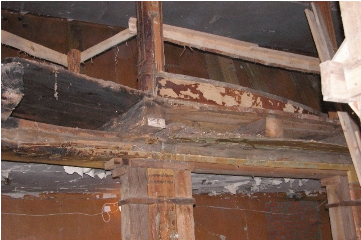
Fot. Nr 83 - Teatr Stary w Lublinie, ul. Jezuicka18,drewniane loże. Strop pomiędzy I i II kondygnacją w trakcie prac rozbiórkowych.Wyk Małgorzata Podgórska - Makal . 06.09. 2007
