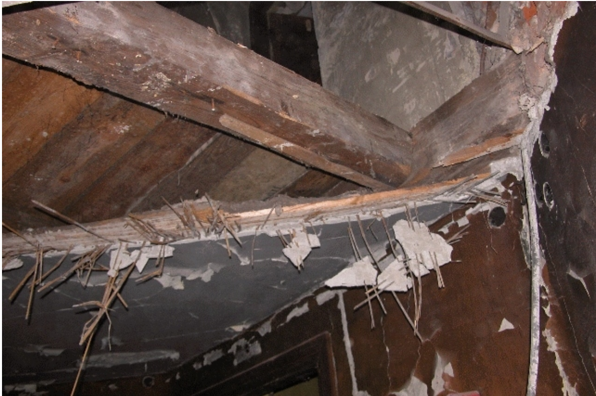
Fot. Nr 85 - Teatr Stary w Lublinie, ul. Jezuicka18,drewniane loże - II kondygnacja. Sufit w trakcie demontowania.Wyk Małgorzata Podgórska - Makal . 09.10. 2007
