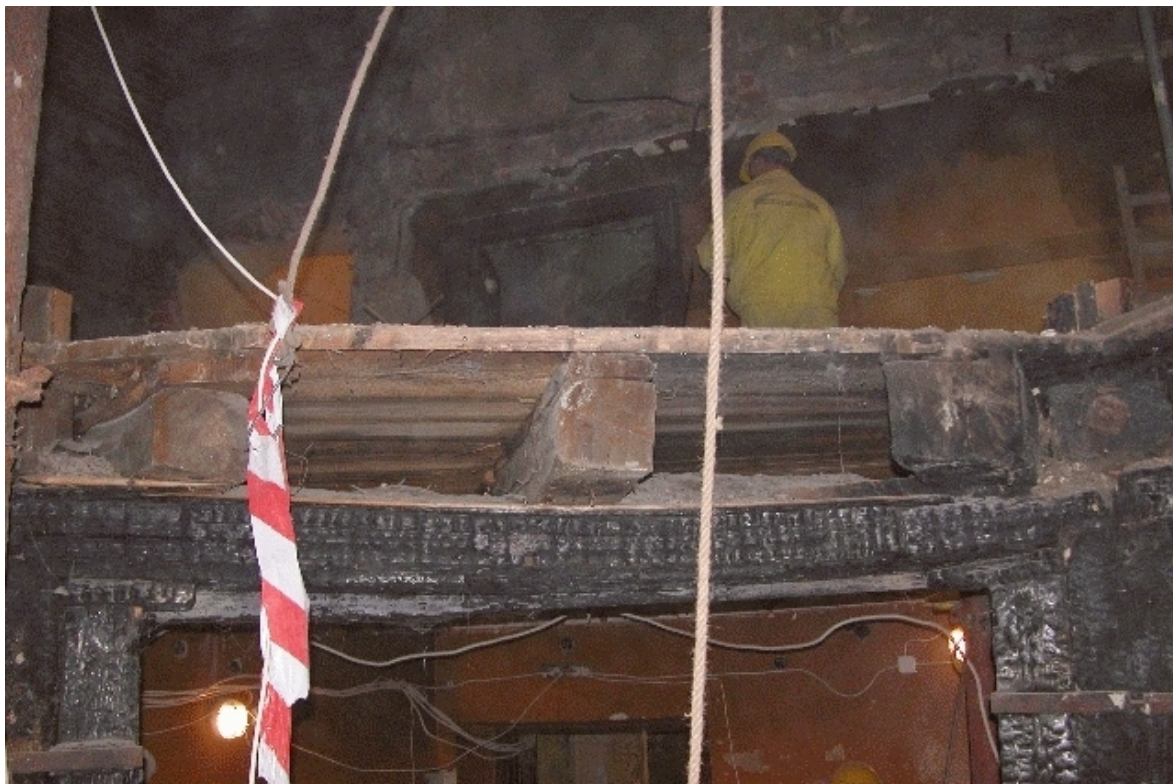
Fot. Nr 109 - Teatr Stary w Lublinie, ul. Jezuicka18,drewniane łoże. Strop I kondygnacji w czasie prac rozbiórkowych. Wyk Małgorzata Podgórska - Makal . 11.10. 2007
