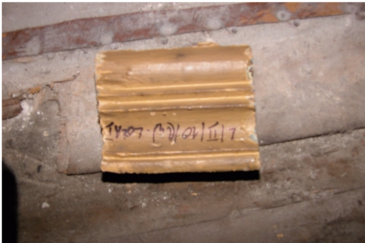
Fot. Nr 67 - Teatr Stary w Lublinie, ul. Jezuicka18,drewniane loże. Sposób opisywania poszczególnych elementów łóż. Wyk Małgorzata Podgórska - Makal . 23.08. 2007
