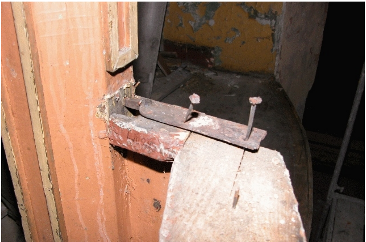
Fot. Nr 64 - Teatr Stary w Lublinie, ul. Jezuicka18,drewniane łoże - II kondygnacja łóż. Ścianki oddzielające poszczególne łoże widowni - sposób kotwienia balustrady do słupów. .Wyk Małgorzata Podgórska - Makal . 23.08. 2007
