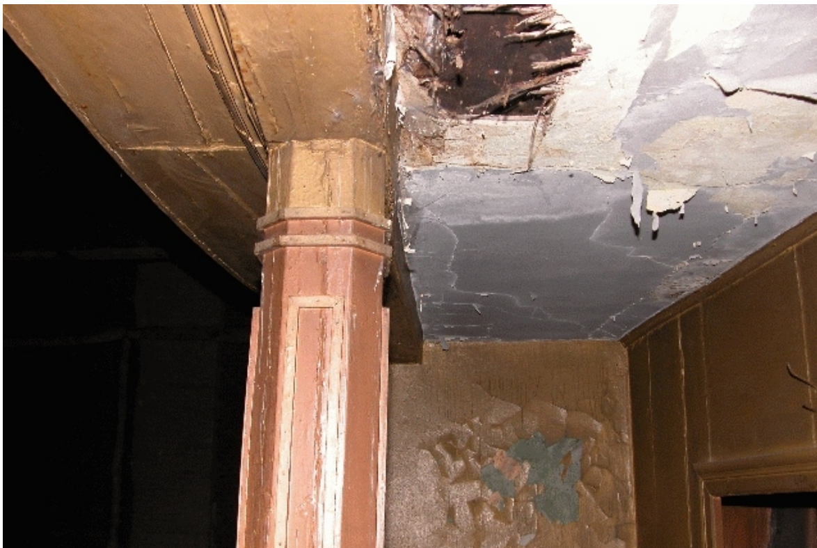
Fot. Nr 58 - Teatr Stary w Lublinie, ul. Jezuicka18,drewniane łoże - II kondygnacja. Sufit w łożach - stan zachowania przed rozpoczęciem prac rozbiórkowych. .Wyk Małgorzata Podgórska - Makal . 20.08. 2007
