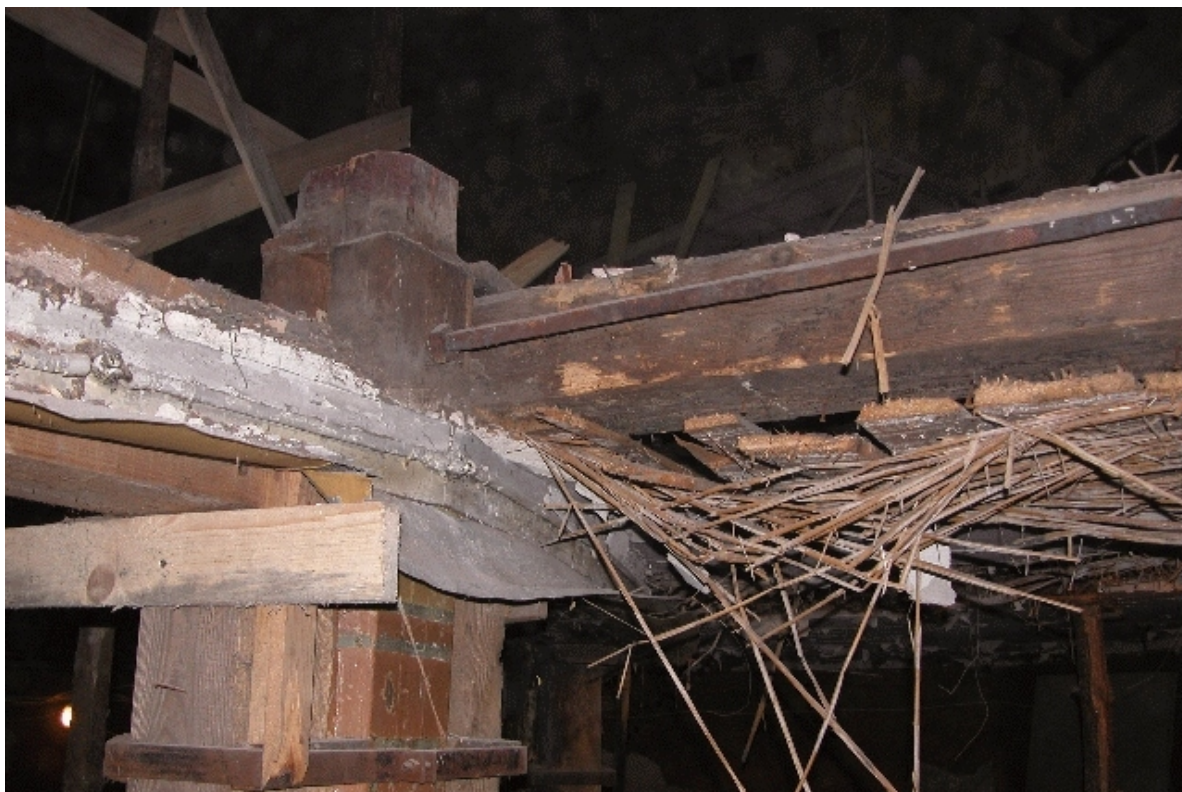
Fot. Nr 113 - Teatr Stary w Lublinie, ul. Jezuicka18,drewniane łoże, Strop I kondygnacji w czasie prac rozbiórkowych. Wyk Małgorzata Podgórska - Makal . 11.10. 2007
