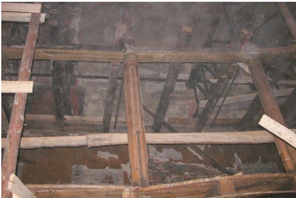
Fot. Nr 94 - Teatr Stary w Lublinie, ul.. Jezuicka18, drewniane łoże, widoczne belki stropowe II kondygnacji łoż. Wyk Małgorzata Podgórska - Ma kal . 10.10. 2007
