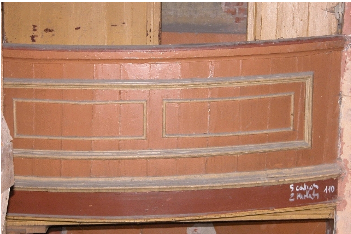
Fot. Nr 39 - Teatr Stary w Lublinie, ul. Jezuicka18,drewniane loże, II kondygnacja - loże. Stan zachowania przed demontażem balustrady.Wyk Małgorzata Podgórska - Makal . 20.08. 2007
