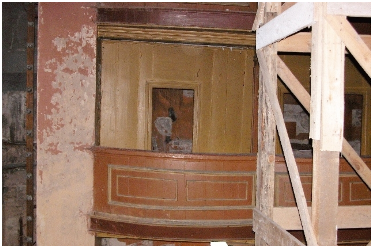
Fot. Nr 40 - Teatr Stary w Lublinie, ul. Jezuicka18,drewniane loże, stan zachowania przed rozpoczęciem prac rozbiórkowych. II kondygnacja - loże. Wyk Małgorzata Podgórska - Makal . 20.08. 2007
