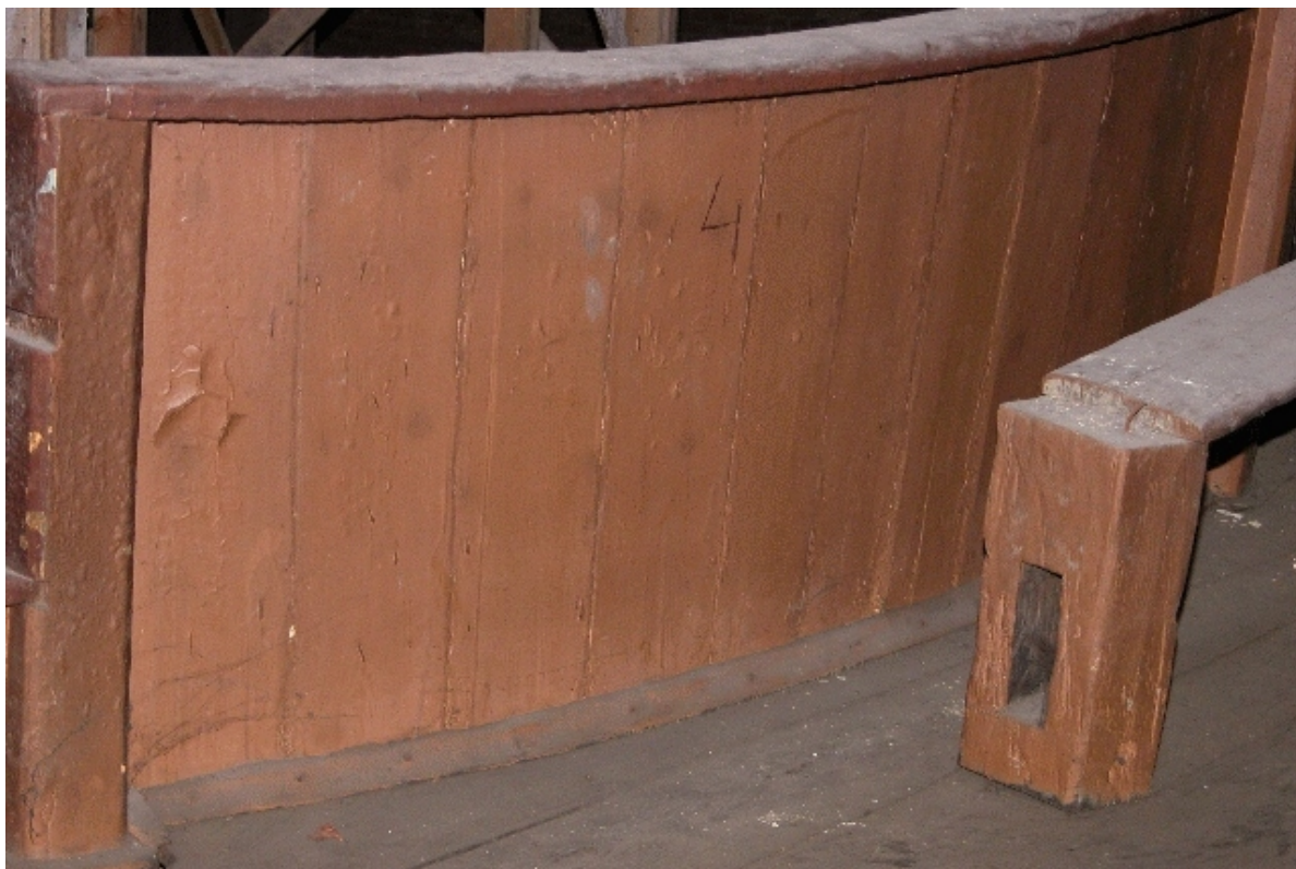
Fot. Nr 7 - Teatr Stary w Lublinie, ul. Jezuicka18,drewniane łóże, stan zachowania przed rozpoczęciem prac rozbiórkowych. III kondygnacja łóż - galeria. Wyk Małgorzata Podgórska - Makal . 20.08. 2007
