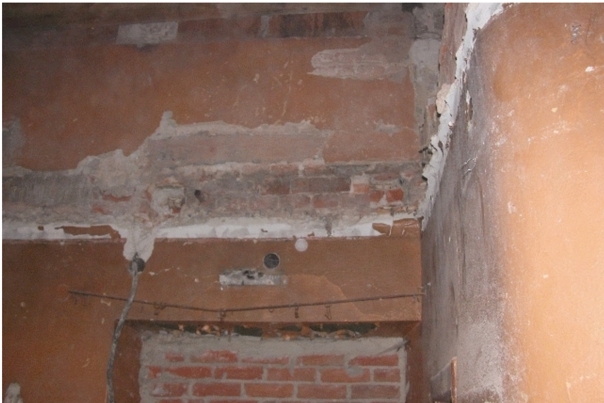
Fot. Nr 99 - Teatr Stary w Lublinie, ul. Jezuicka18, drewniane łoże, Widoczne gniazda po belkach stropowych II kondygnacji. Wyk. Małgorzata Podgórska-Makal 12.10.2007
