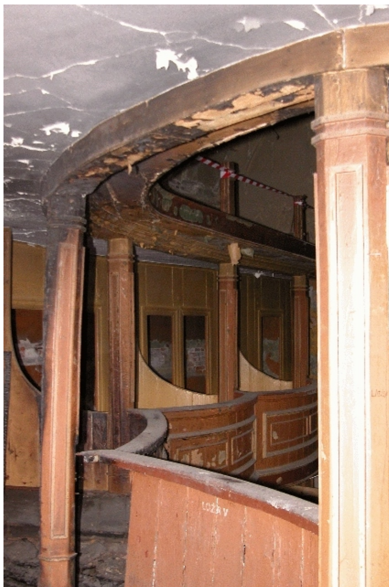
Fot. Nr 50 - Teatr Stary w Lublinie, ul. Jezuicka 18, drewniane loże, stan zachowania przed rozpoczęciem prac rozbiórkowych. II kondygnacja. Widoczne ścianki oddzielające poszczególne loże widowni. .Wyk Małgorzata Podgórska - Makal . 20.08. 2007
