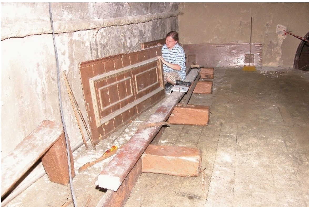
Fot. Nr 20 - Teatr Stary w Lublinie, ul. Jezuicka 18, drewniane łoże, III kondygnacja łoż - galeria. Panel balustrady po zdemontowaniu. Wyk Małgorzata Podgórska - Makal . 20.08. 2007
