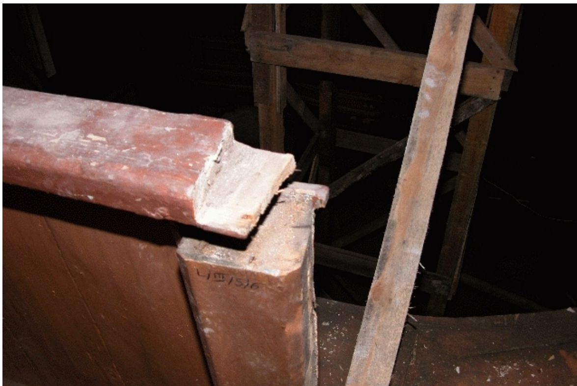
Fot. Nr 19 - Teatr Stary w Lublinie, ul. Jezuicka 18, drewniane łoże. III kondygnacja łoż - galeria. Poręcz galerii w trakcie demontażu. Wyk Małgorzata Podgórska - Makal . 20.08. 2007
