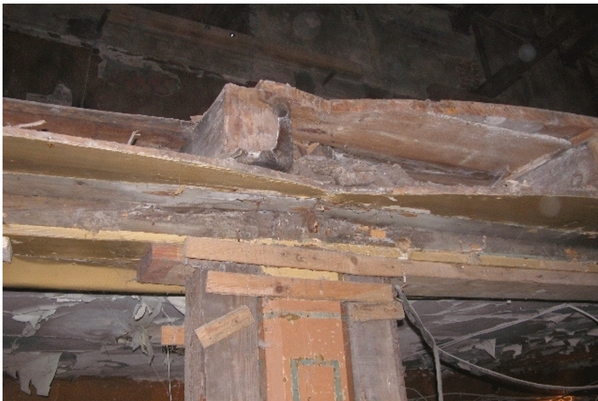
Fot. Nr 117 - Teatr Stary w Lublinie, ul. Jezuicka18,drewniane łoże. Strop I kondygnacji w czasie prac rozbiórkowych. Wyk Małgorzata Podgórska - Makal . 11.10. 2007
