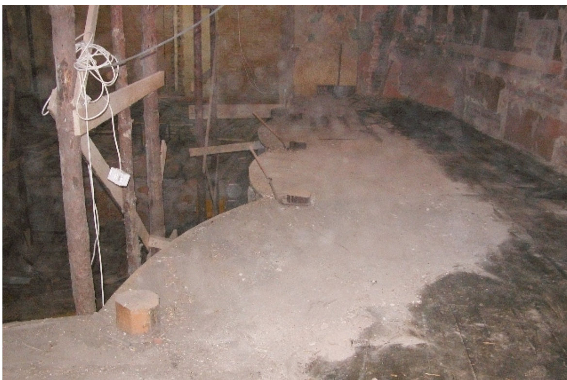
Fot. Nr 118 - Teatr Stary w Lublinie, ul. Jezuicka18,drewniane łoże. Strop I kondygnacji w czasie prac rozbiórkowych. Wyk Małgorzata Podgórska - Makal . 11.10. 2007
