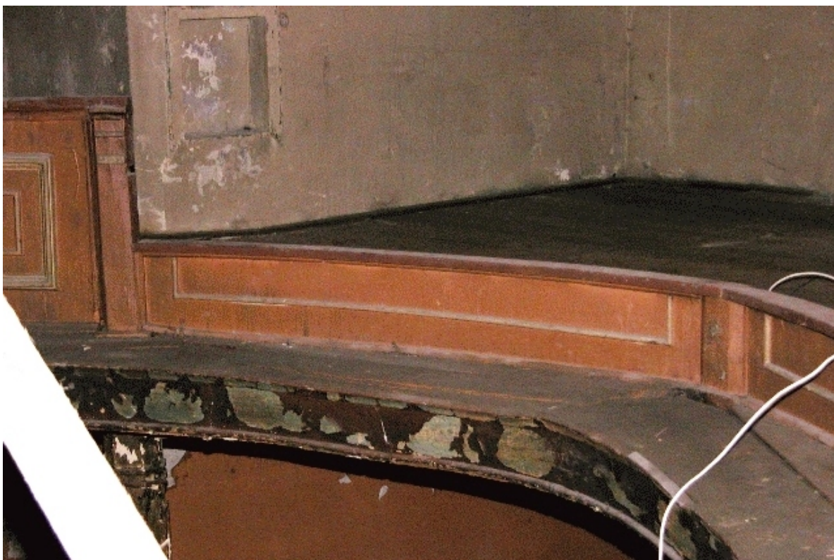
Fot. Nr 14 - Teatr Stary w Lublinie, ul. Jezuicka18,drewniane łóże, stan zachowania przed rozpoczęciem prac rozbiórkowych. III kondygnacja łóż - galeria. Wyk Małgorzata Podgórska - Makal .20.8. 2007
