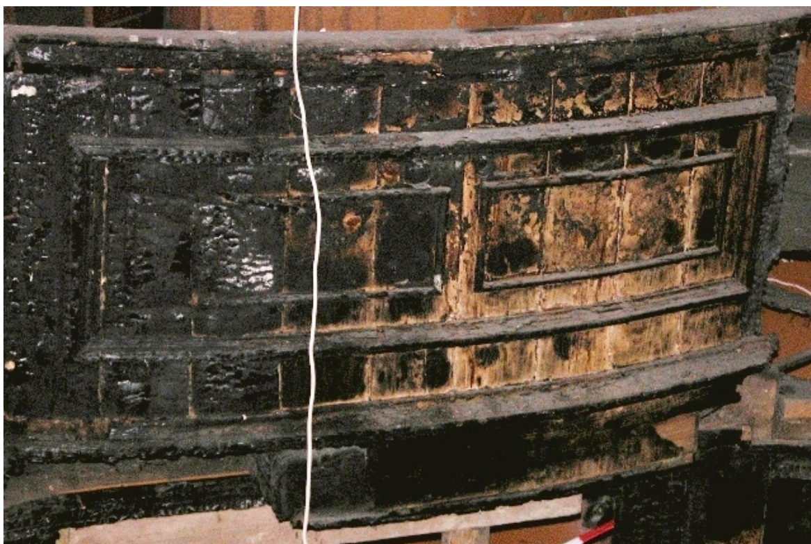
Fot. Nr 36 - Teatr Stary w Lublinie, ul. Jezuicka18,drewniane łoże, stan zachowania przed rozpoczęciem prac rozbiórkowych. II kondygnacja - łoże. Widoczne nadpalone balkony. Wyk Małgorzata Podgórska - Makal . 20.08. 2007
