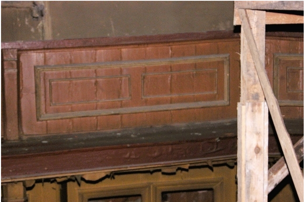
Fot. Nr 11 - Teatr Stary w Lublinie, ul. Jezuicka18,drewniane loże, stan zachowania przed rozpoczęciem prac rozbiórkowych. III kondygnacja łóż - galeria. Wyk Małgorzata Podgórska - Makal . 20.08. 2007
