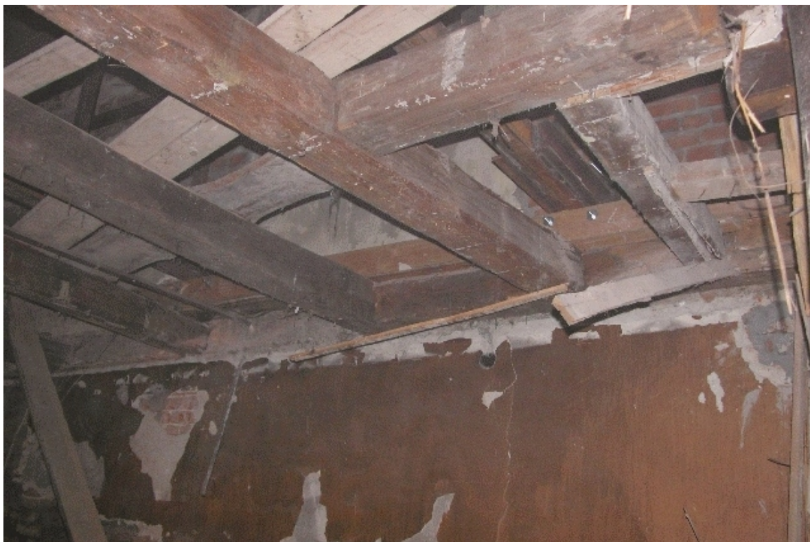
Fot. Nr 93 - Teatr Stary w Lublinie, ul. Jezuicka18, drewniane łoże, strop nad II kondygnacją w czasie prac rozbiórkowych. Wyk Małgorzata Podgórska - Makal . 10.10. 2007
