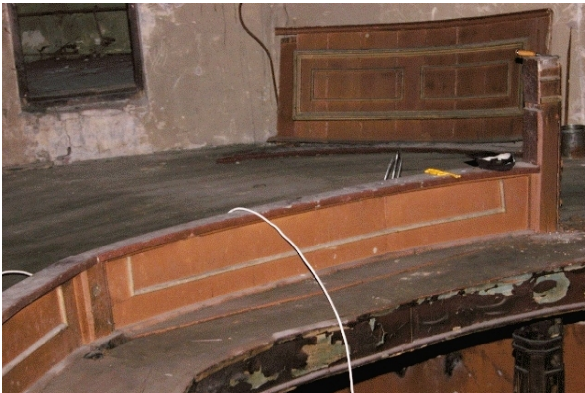
Fot. Nr 13 - Teatr Stary w Lublinie, ul. Jezuicka18,drewniane łóże, stan zachowania przed rozpoczęciem prac rozbiórkowych. III kondygnacja łóż - galeria. Wyk Małgorzata Podgórska - Makal . 20.08. 2007
