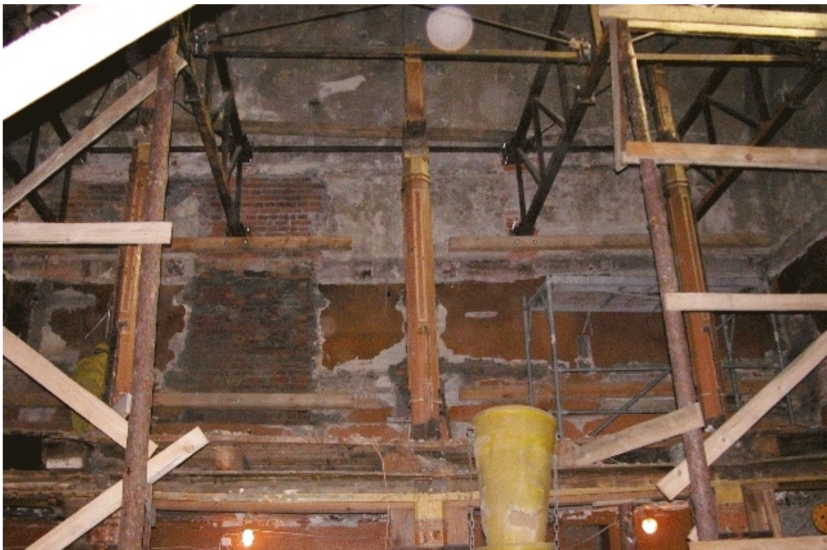
Fot. Nr 86 - Teatr Stary w Lublinie, ul. Jezuicka18,drewniane loże, stan po zdemontowaniu III kondegnacji - galerii. Wyk Małgorzata Podgórska - Makal . 09.10. 2007
