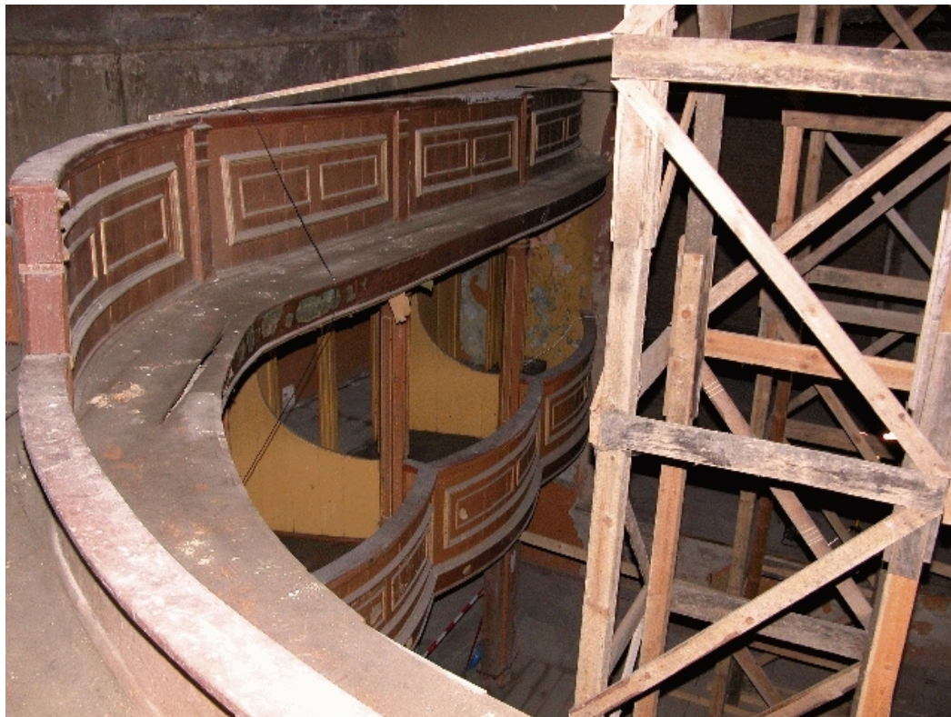
Fot. Nr 10 - Teatr Stary w Lublinie, ul. Jezuicka18,drewniane loże, stan zachowania przed rozpoczęciem prac rozbiórkowych. III kondygnacja łóż - galeria. Wyk Małgorzata Podgórska - Makal . 03.07. 2007
