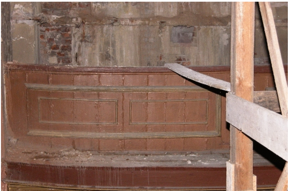
Fot. Nr 6 - Teatr Stary w Lublinie, ul. Jezuicka 18, drewniane łóże, stan zachowania przed rozpoczęciem prac rozbiórkowych. III kondygnacja łóż - galeria. Wyk Małgorzata Podgórska - Makal . 20.08. 2007
