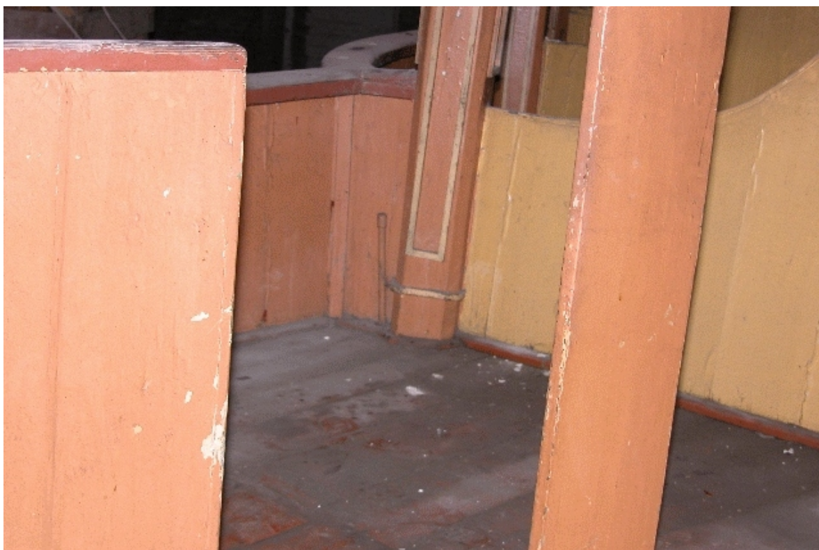
Fot. Nr 44 - Teatr Stary w Lublinie, ul. Jezuicka18,drewniane łoże, stan zachowania przed rozpoczęciem prac rozbiórkowych. II kondygnacja - łoże. Widoczne wnętrza łóż. Wyk Małgorzata Podgórska - Makal. 20.08. 2007
