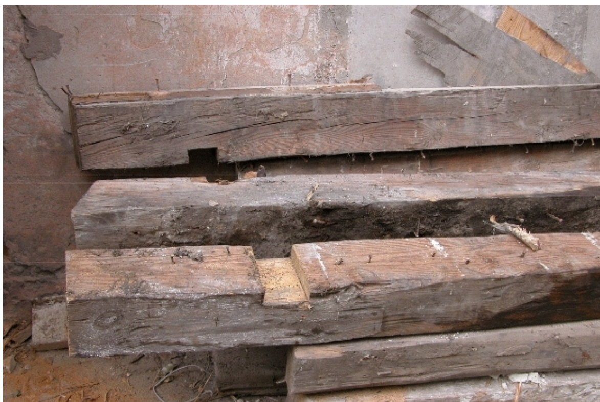
Fot. Nr 120 - Teatr Stary w Lublinie, ul. Jezuicka18,drewniane łoże. Belki stropowe po zdemontowaniu. Wyk. Małgorzata Podgórska - Makal . 11.10. 2007
