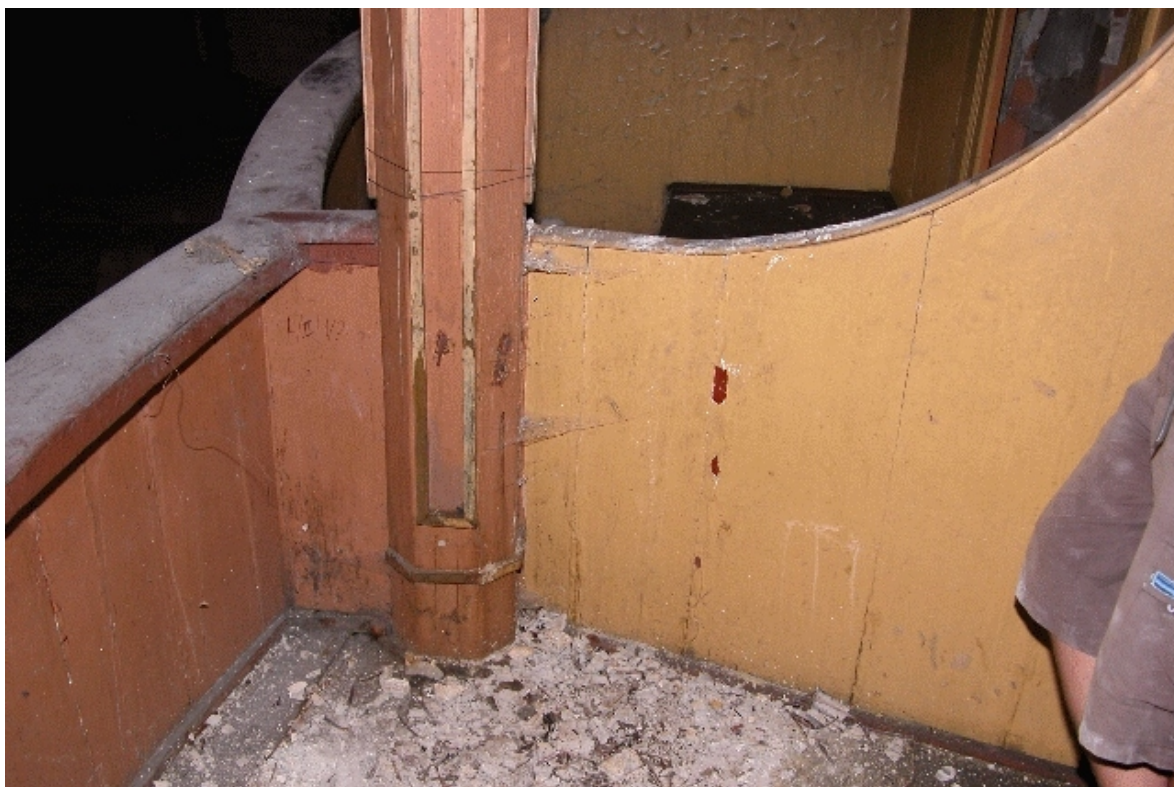
Fot. Nr 56 - Teatr Stary w Lublinie, ul. Jezuicka 18, drewniane łoże, stan zachowania przed rozpoczęciem prac rozbiórkowych. II kondygnacja. Wnętrze łoża. Wyk Małgorzata Podgórska - Makal . 20.08. 2007
