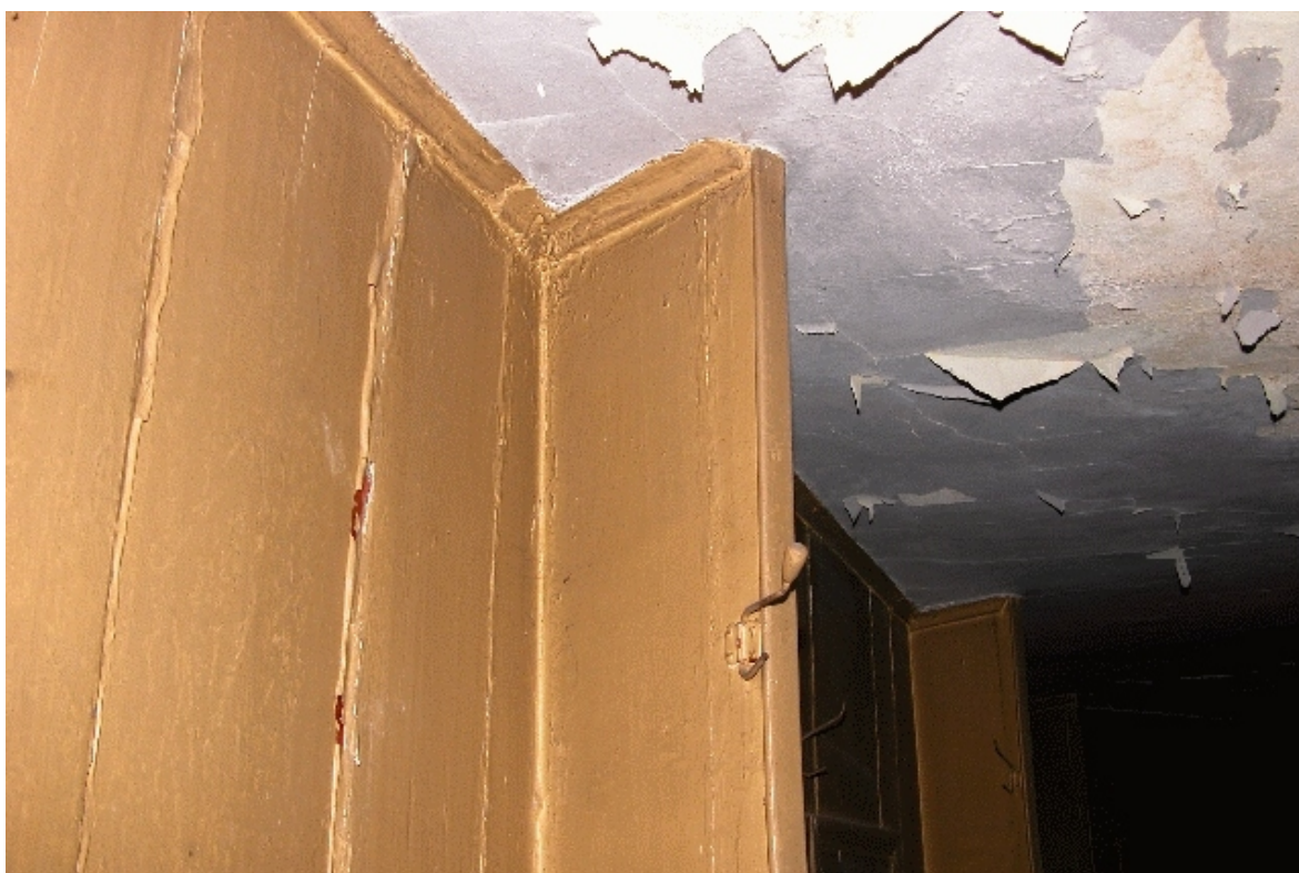
Fot. Nr 54 - Teatr Stary w Lublinie, ul... Jezuicka18, drewniane loże, stan zachowania przed rozpoczęciem prac rozbiórkowych. II kondygnacja. Ścianka oddzielająca lożę widowni od korytarza i poszczególne loże, .Wyk Małgorzata Podgórska - Makal . 20.08. 2007
