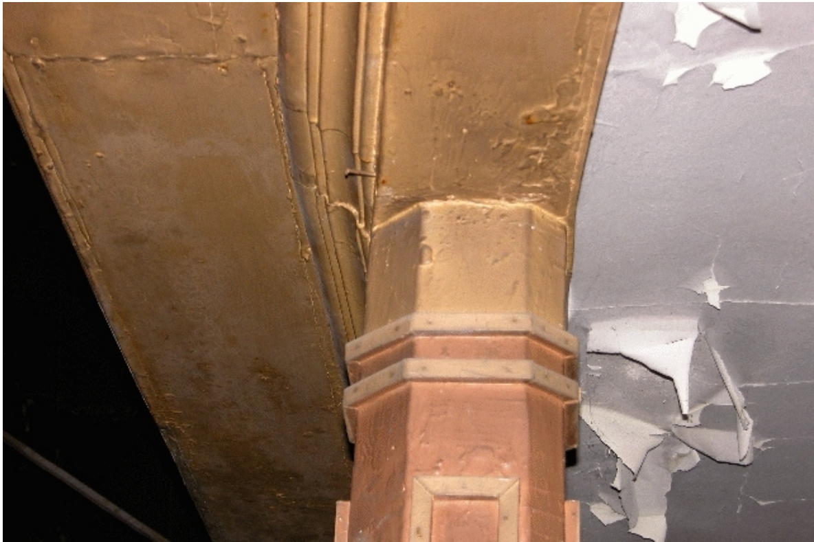
Fot. Nr 51 - Teatr Stary w Lublinie, ul. Jezuicka18,drewniane loże, II kondygnacja. Wykończenie kolumn - "głowica" oraz listwa profilowana wykańczająca galerię - III kondygnację, od spodu. Wyk Małgorzata Podgórska - Makal . 20.08. 2007
