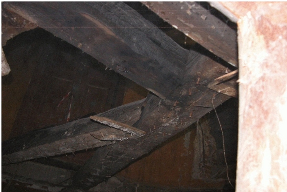
Fot. Nr 119 - Teatr Stary w Lublinie, ul. Jezuicka18,drewniane łoże. Strop I kondygnacji w czasie prac rozbiórkowych. Widoczny układ belek stropowych. Wyk. Małgorzata Podgórska - Makal 12.10. 2007
