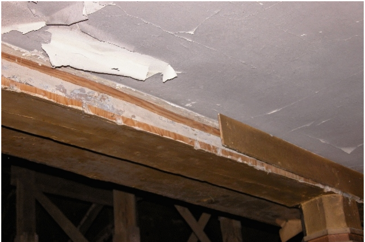
Fot. Nr 61 - Teatr Stary w Lublinie, ul. Jezuicka18,drewniane łoże -II kondygnacja. Stan w trakcie demontowania wtórnego obłożeniabelek konstrukcji wykonanego z płyty pilśniowej twardej. Wyk Małgorzata Podgórska - Makal . 22.08. 2007
