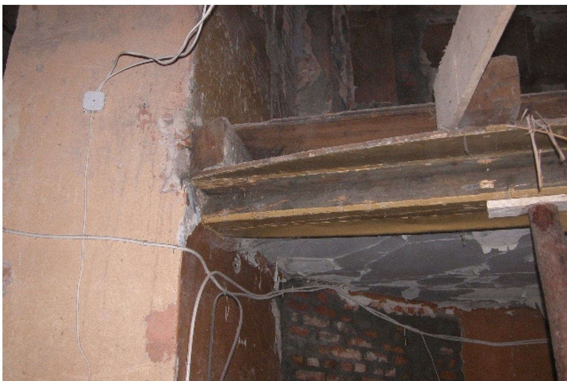
Fot. Nr 116 - Teatr Stary w Lublinie, ul. Jezuicka18,drewniane loże. Strop I kondygnacji w czasie prac rozbiórkowych. Wyk Małgorzata Podgórska - Makal . 11.10. 2007
