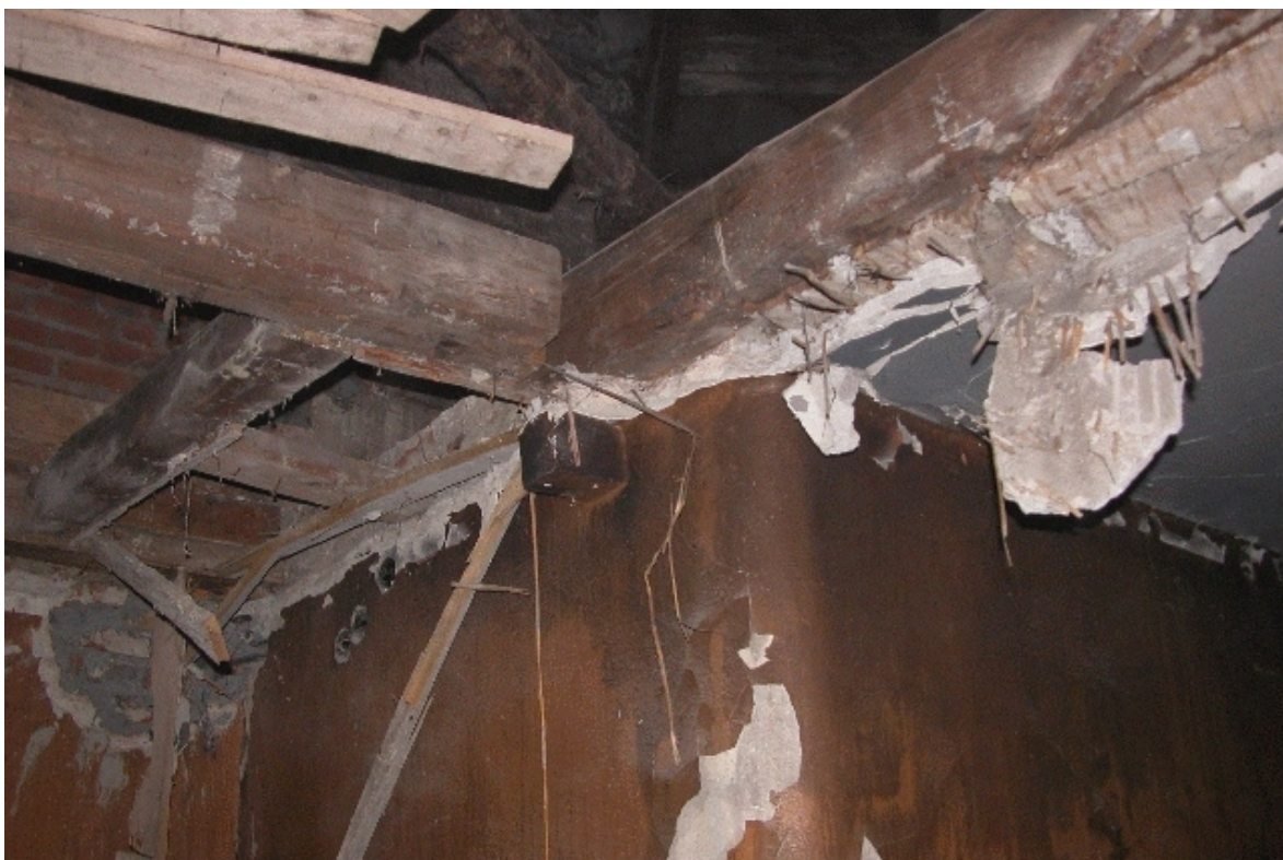
Fot. Nr 105 - Teatr Stary w Lublinie, ul. Jezuicka18,drewniane loże, Strop I kondygnacji w czasie prac rozbiórkowych.Wyk. Małgorzata Podgórska-Makal 12.10.2007
