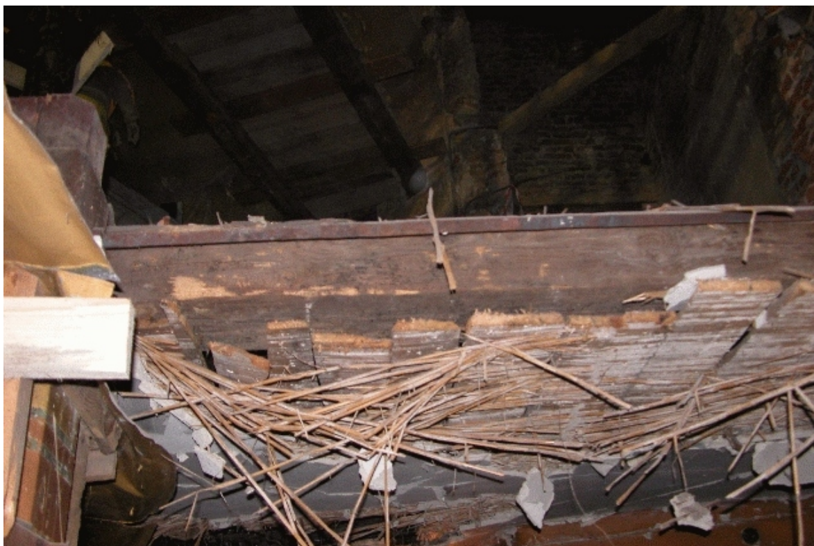
Fot. Nr 110 - Teatr Stary w Lublinie, ul. Jezuicka18,drewniane łoże. Strop I kondygnacji w czasie prac rozbiórkowych. Wyk Małgorzata Podgórska - Makal . 12.10. 2007
