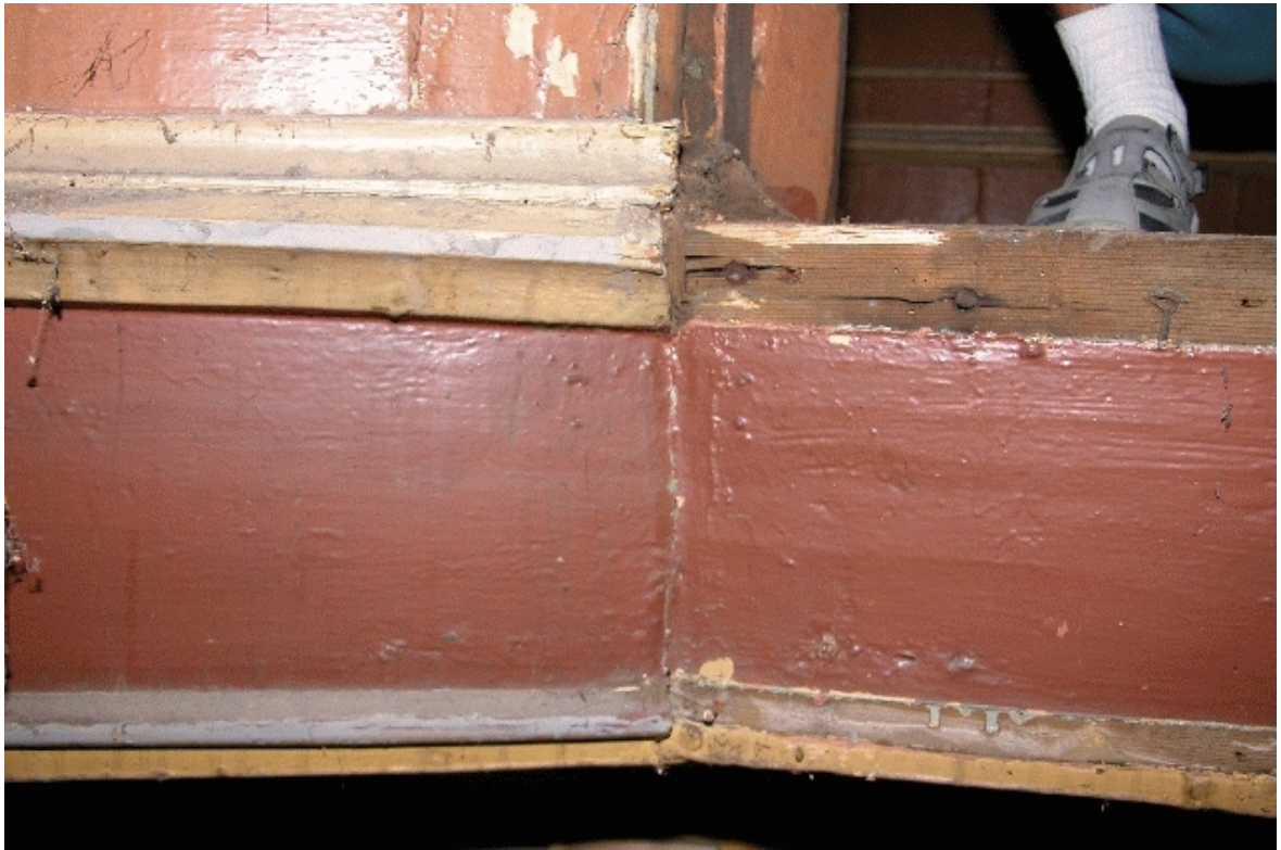
Fot. Nr 63 - Teatr Stary w Lublinie, ul. Jezuicka18,drewniane łoże - II kondygnacja. Widoczne obłożenie partii cokołowej.Wyk Małgorzata Podgórska - Makal . 23.08. 2007
