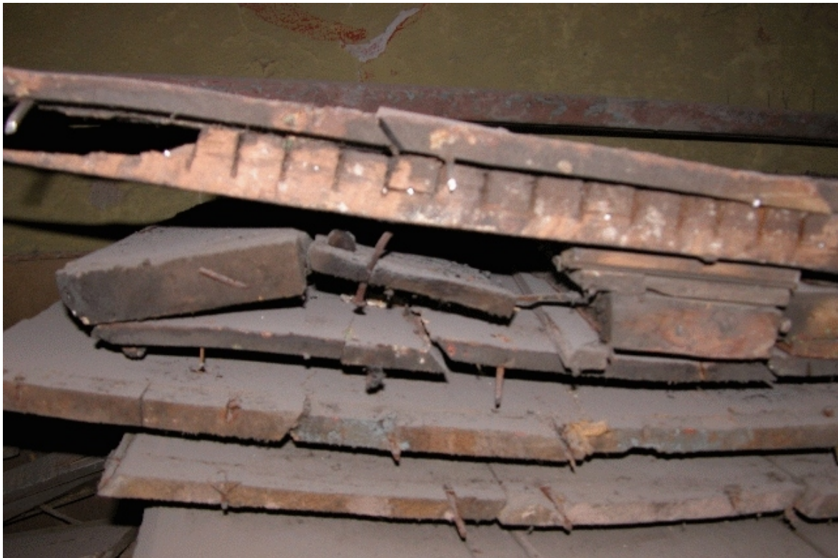
Fot. Nr 107 - Teatr Stary w Lublinie, ul. Jezuicka18,drewniane łoże. Złożone, zdemontowane panele balkonów II kondygnacji. Wyk. Małgorzata Podgórska-Makał 12.10.2007
