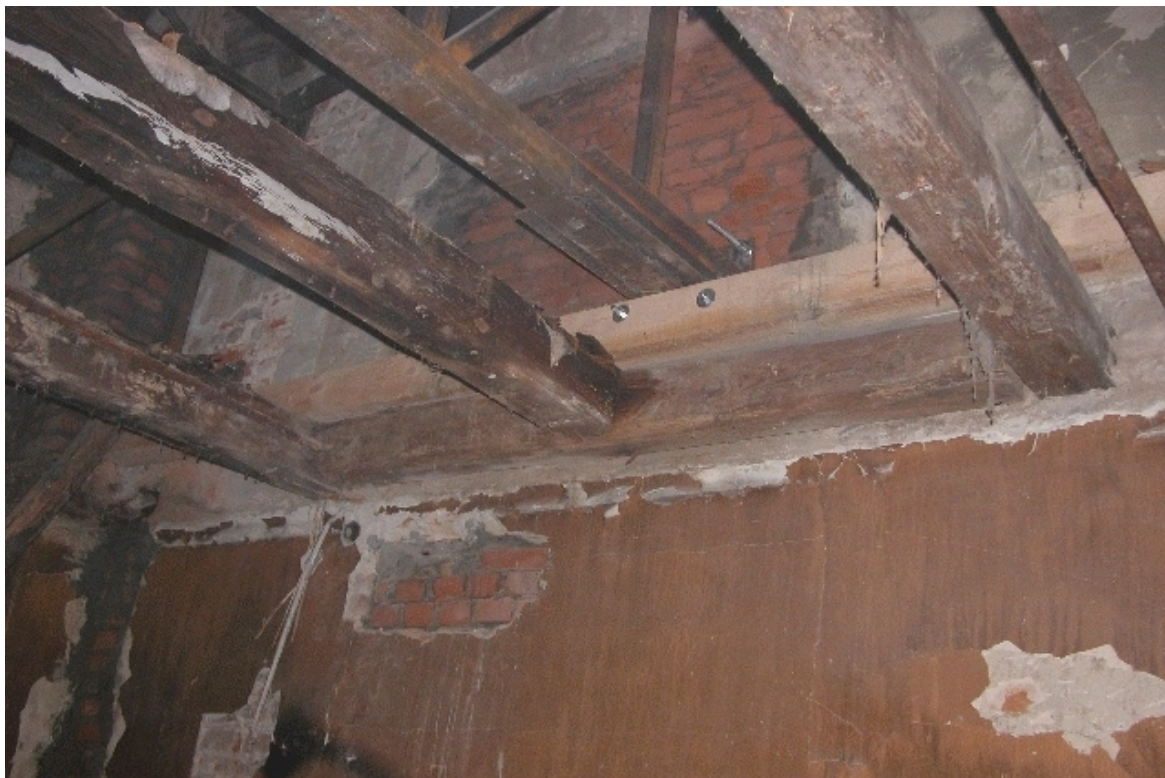
Fot. Nr 95 - Teatr Stary w Lublinie, ul. Jezuicka18,drewniane loże. Widoczne belki stropowe II kondygnacji.Wyk. Małgorzata Podgórska-Makal 10.10.2007
