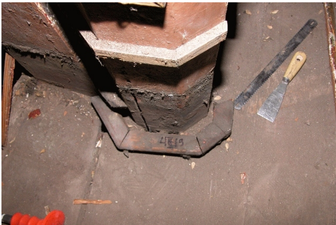
Fot. Nr 70 - Teatr Stary w Lublinie, ul. Jezuicka18, drewniane łoże - II kondygnacja. Widoczne obłożenie słupa. L/II/9. Wyk Małgorzata Podgórska - Makal . 24.08. 2007
