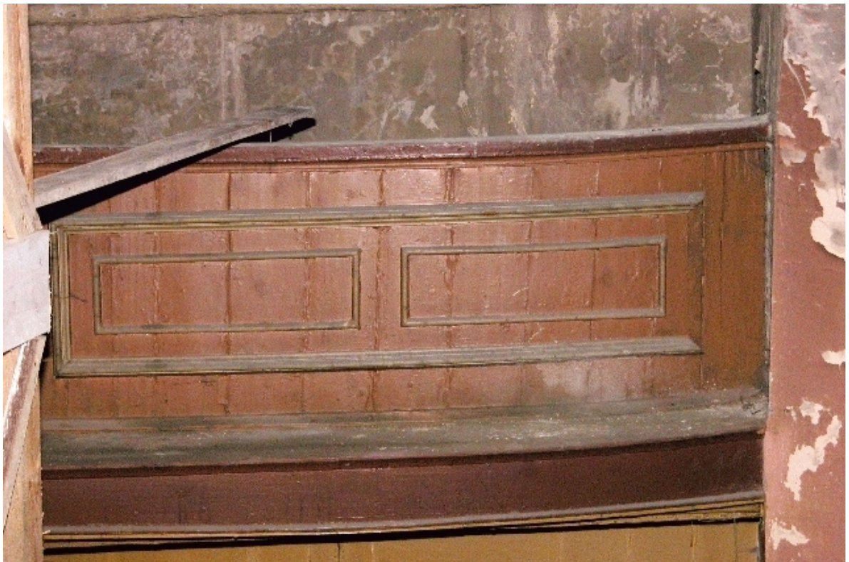
Fot. Nr 12 - Teatr Stary w Lublinie, ul. Jezuicka18,drewniane loże, stan zachowania przed rozpoczęciem prac rozbiórkowych. III kondygnacja łóż - galeria. Wyk Małgorzata Podgórska - Makal . 20.08. 2007
