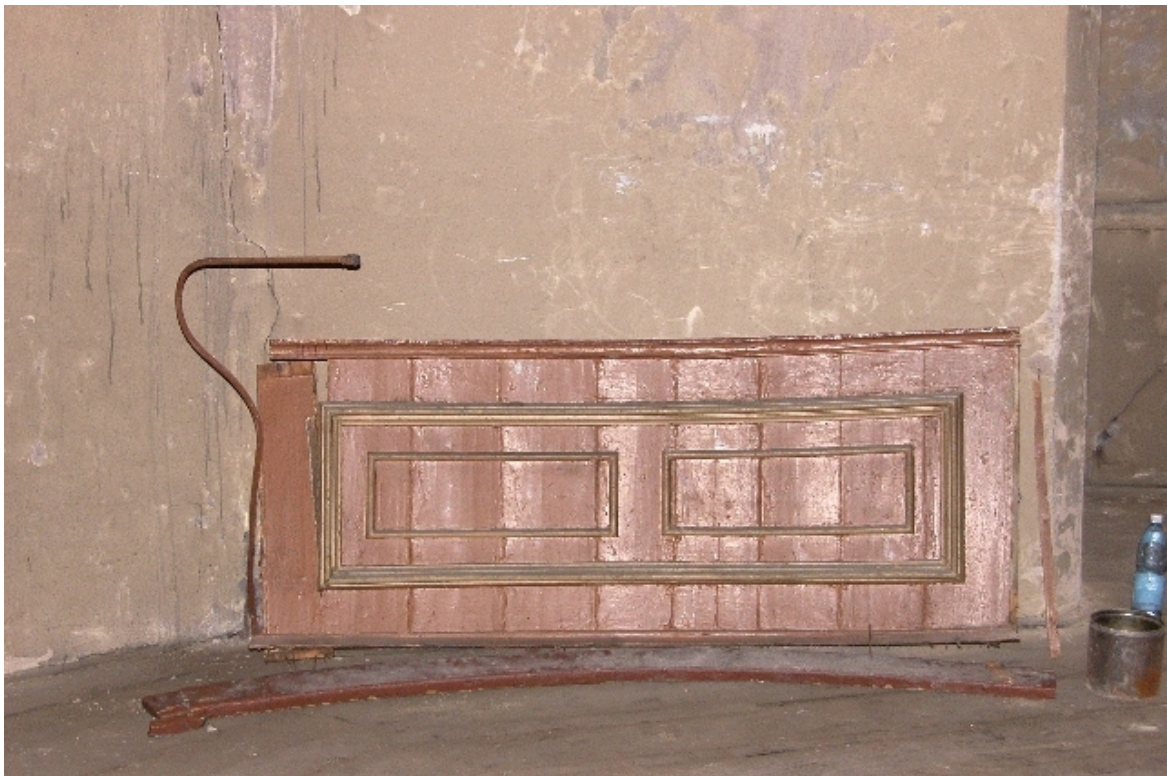
Fot. Nr 21 - Teatr Stary w Lublinie, ul. Jezuicka 18, drewniane łoże, III kondygnacja łoż - galeria. Panel balustrady po zdemontowaniu. Wyk Małgorzata Podgórska - Makal . 20.08. 2007
