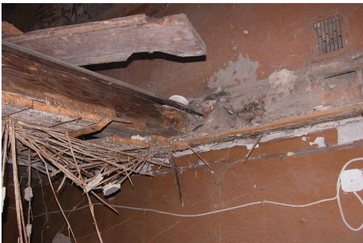
Fot. Nr 114 - Teatr Stary w Lublinie, ul. Jezuicka18,drewniane łoże. Strop I kondygnacji w czasie prac rozbiórkowych. Wyk Małgorzata Podgórska - Makal . 11.10. 2007
