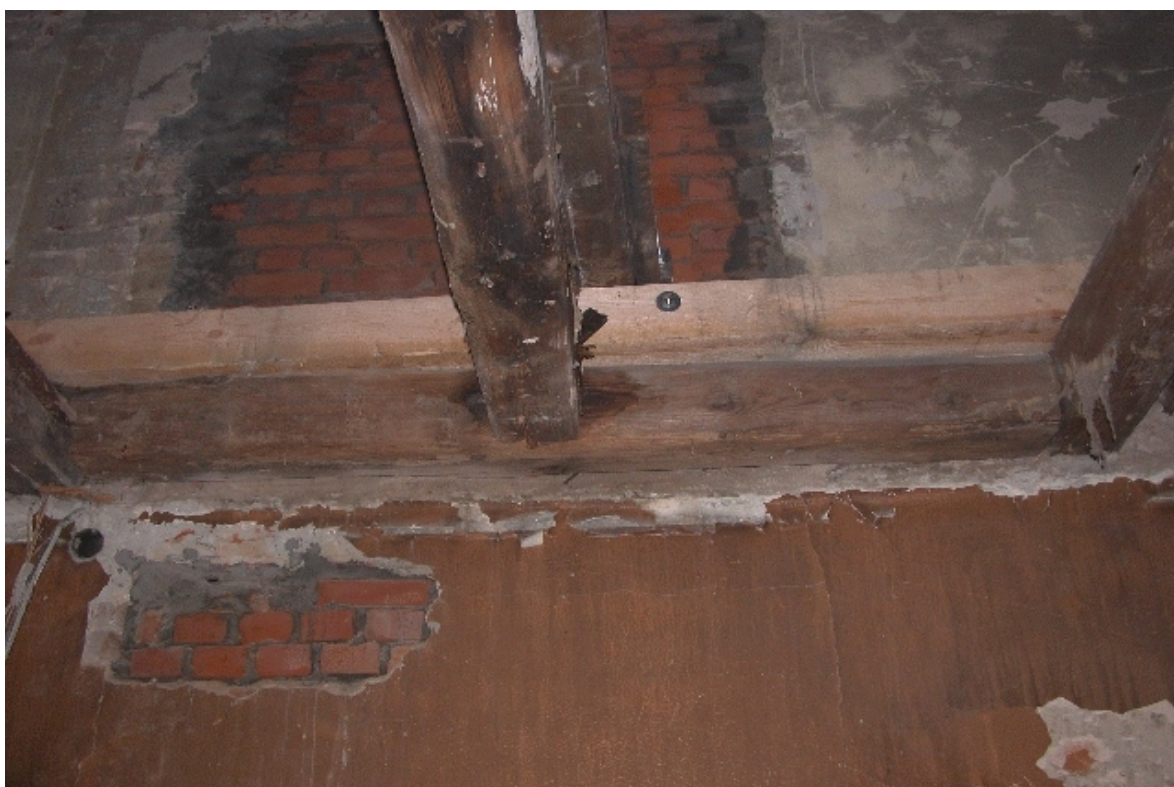
Fot. Nr 102 - Teatr Stary w Lublinie, ul. Jezuicka 18. Belki stropowe I kondygnacji po ich odsłonięciu. Wyk Małgorzata Podgórska - Makal . 12.10. 2007
