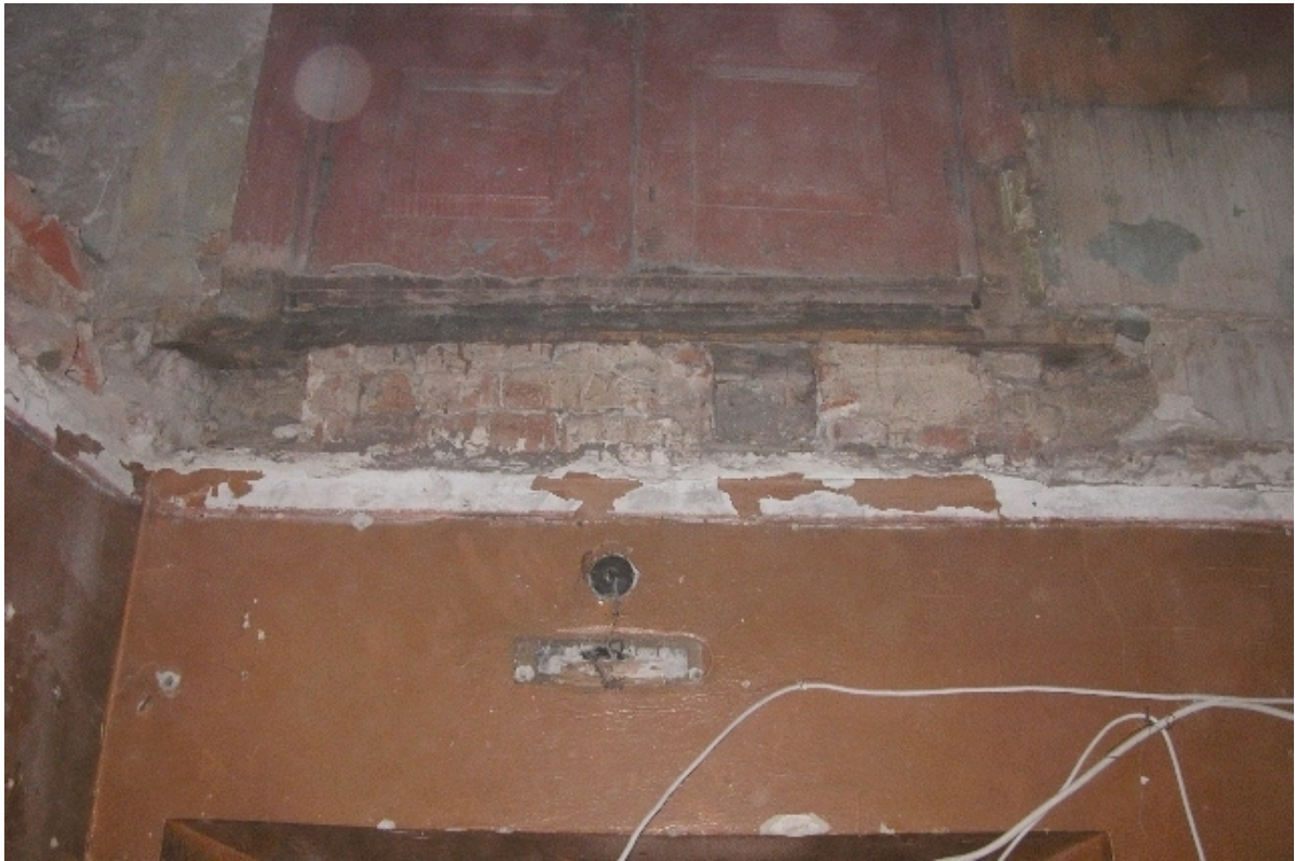
Fot. Nr 97 - Teatr Stary w Lublinie, ul. Jezuicka 18, drewniane łoże. Widoczne gniazda po belkach stropowych II kondygnacji. Wyk. Małgorzata Podgórska-Makal 12.10.2007
