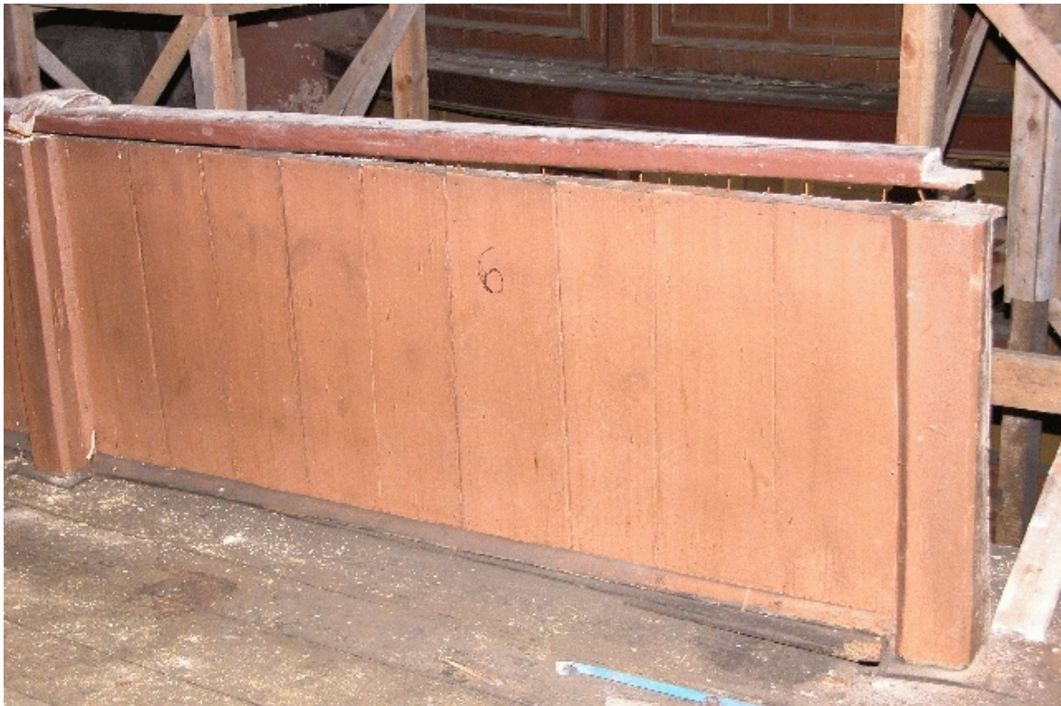
Fot. Nr 17 - Teatr Stary w Lublinie, ul. Jezuicka18,drewniane loże, stan zachowania przed rozpoczęciem prac rozbiórkowych. III kondygnacja łóż - galeria. Widok od strony miejsc dla publiczności. Wyk Małgorzata Podgórska - Makal . 20.08. 2007
