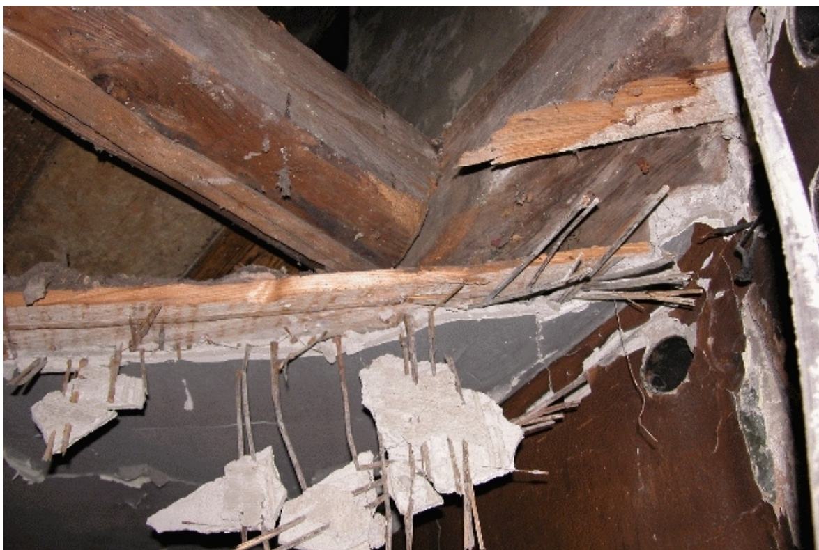
Fot. Nr 87 - Teatr Stary w Lublinie, ul. Jezuicka18,drewniane loże - II kondygnacja. Sufit w trakcie demontowania.Wyk Małgorzata Podgórska - Makal . 09.10. 2007
