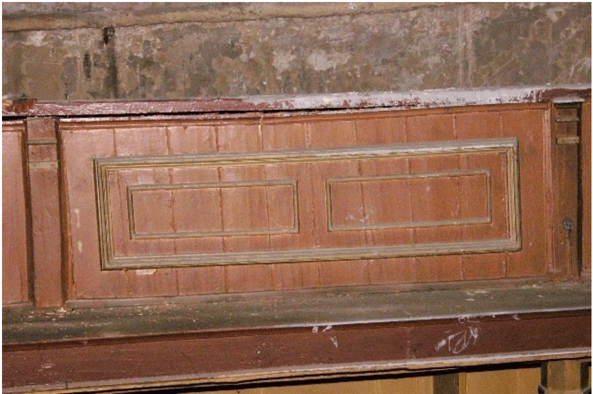
Fot. Nr 15 - Teatr Stary w Lublinie, ul. Jezuicka 18, drewniane łóże, stan zachowania przed rozpoczęciem prac rozbiórkowych. III kondygnacja łóż - galeria. Wyk Małgorzata Podgórska - Makal .20.08. 2007
