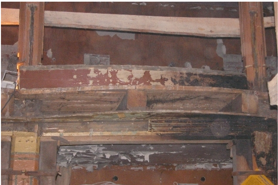
Fot. Nr 82 - Teatr Stary w Lublinie, ul. Jezuicka18,drewniane loże, stan zachowania przed rozpoczęciem prac rozbiórkowych. II kondygnacja łóż - balkony. Widoczne ścianki oddzielające poszczególne loże widowni .Wyk Małgorzata Podgórska - Makal . 03.07. 2007
