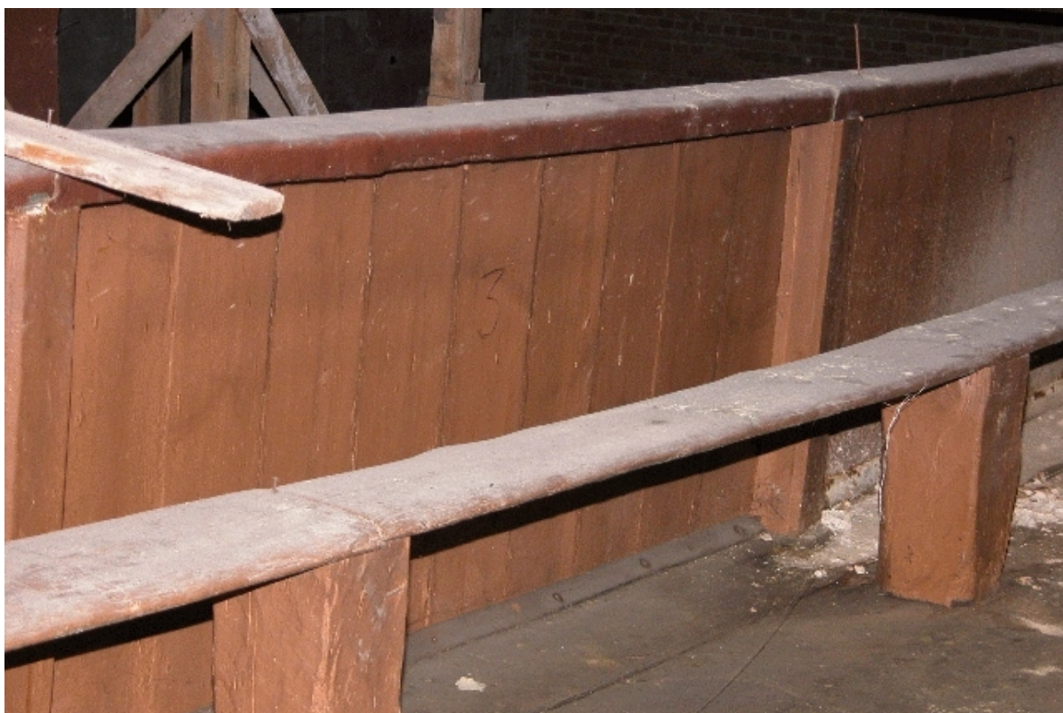
Fot. Nr 8 - Teatr Stary w Lublinie, ul. Jezuicka18,drewniane łóże, stan zachowania przed rozpoczęciem prac rozbiórkowych. III kondygnacja łóż - galeria. Wyk Małgorzata Podgórska - Makal . 20.08. 2007
